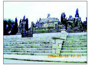
Fig. 3/XIII- Ruína do Monumento ao Sagrado Coração de Jesús, destruído em 1936
