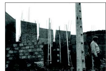
Fig. 35/XVII- Idem. Poste doado pela EDP para estruturar o elemento central.
