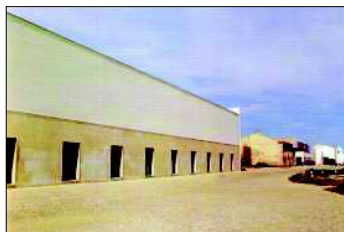
Fig. 40/XXI- Conclusão do Corpo A do projecto Carreira. Fonte: Arbitécti , nº 25
