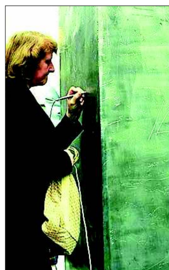
Fig. 51/XVI- Idem, Transeunte escreve o seu nome sobre a superfície de revestida a chumbo do pilar
