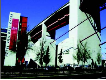
Fig. 41/XV- Maciço de Amarração Norte da Ponte 25 de Abril. Ocupação dos terrenos circundantes.
