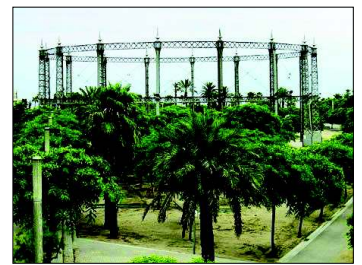
Fig. 28/XXII- Claudi Gil, Estructura del Gasòmetre , 1868, aço, Barcelona.
