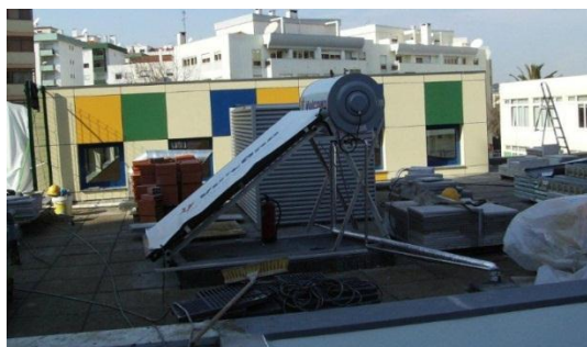
Fig. 47 – Instalação de Painéis Solares na Escola Primária EB1 D. Pedro V, em Linda-a-Velha
