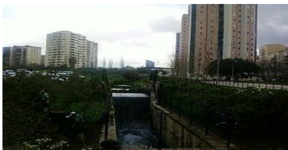
Fig. 24 - Afunilamento junto à parte baixa de Miraflores
