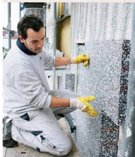
Je nach Gebäudezustand kann rund 40 Prozent der Heizenergie durch die Außenwände entweichen. Abhilfe schafft fachgerechte Fassadendämmung. Bild: HL/Caparol
