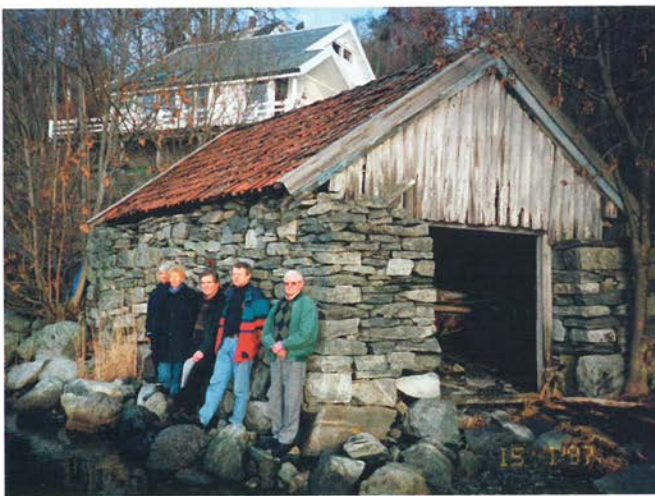
Naustet i Vika på Finnøy før arbeidet vart sett i gong. Biletet er frå synfaring med eigar Leidulf Bergsvik, Sissel Bjerke frå Landbrukskontoret på Finnøy og tradisjonsberarane Svein Kloster og Per Surnevik.
