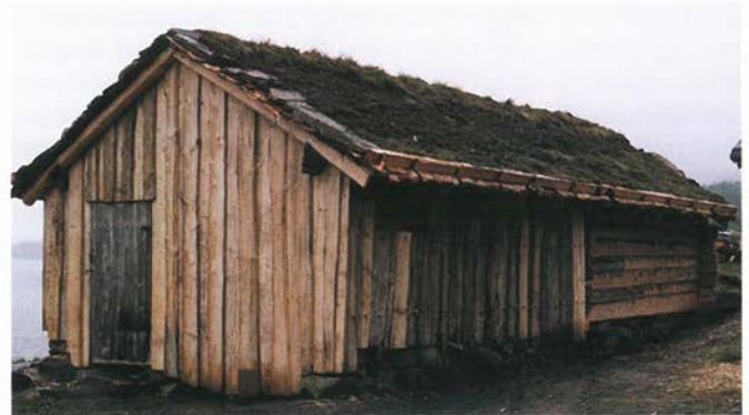
Det ferdig restaurerte stølshuset på Sandsa.
