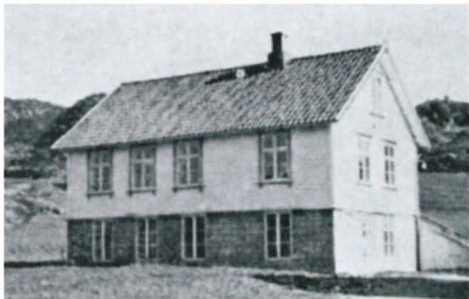
1919 – 1963, "Betel" , Erøy, Erfjord, Suldal. Rive for å gi plass til nytt på same staden.
