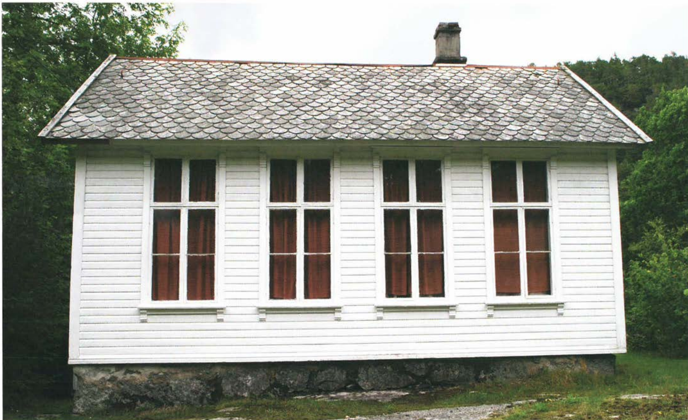
Skulehuset i Kvalvåg, Strand, der den spennande Kvalvågbasaren gjekk føre seg.
