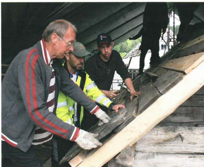
Restaureringsarbeidet i Viga blir brukt som ein lærearena. Lokale handverkarar har hjelpt oss med å henta fram kunnskapen om legging av helletak. Her ser me Jens Vestersjø og Arnfinn Olsen saman med museumshandverkar Sven Hoftun.
