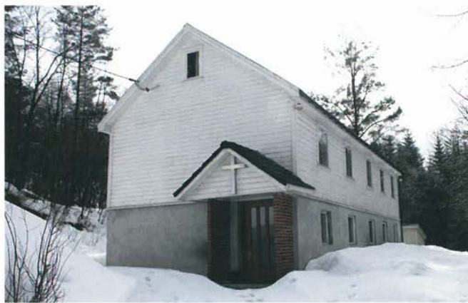
1954, Fjellet, Erfjord, Suldal. Opphavleg butikkbygning frå Hålandsosen.
