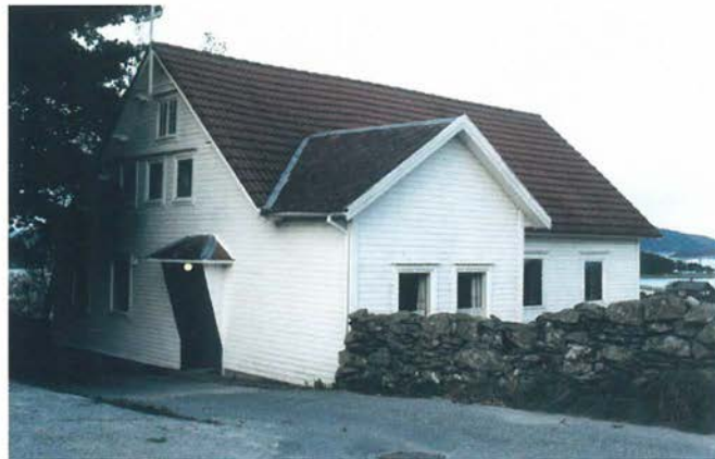
1919 – 2002, Bru og Sokn, Rennesøy . Opphavleg eit gammalt skulehus frå Tau. Rive då det nye bedehuset stod ferdig eit stykke unna.
