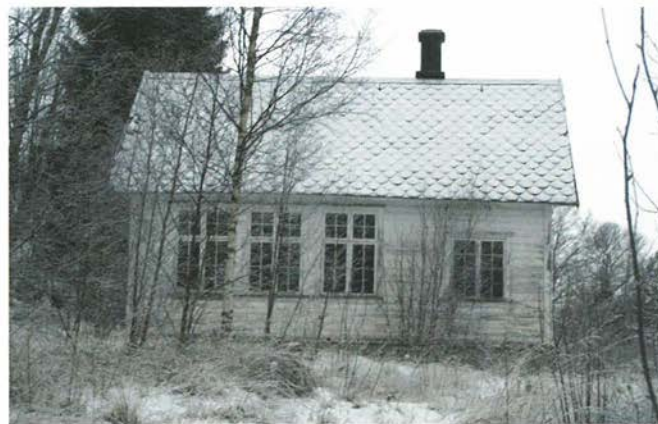
1962 – ca. 1972, Tuftene, Hjelmeland. Skulehus bygd 1928. Bedehus mellom 1962 og ca 1972. Bygningen står.
