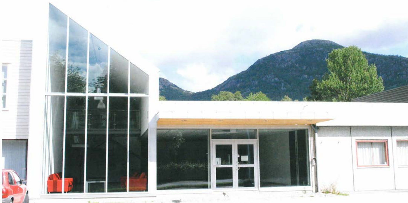
Jørpeland bedehus, Strand, med ny foajé som knyter det saman med nabobygget "Kraftverket", ei stifting der det blir drive ungdomsarbeid av Jørpeland sokneråd og dei ulike misjonsorganisasjonane.
