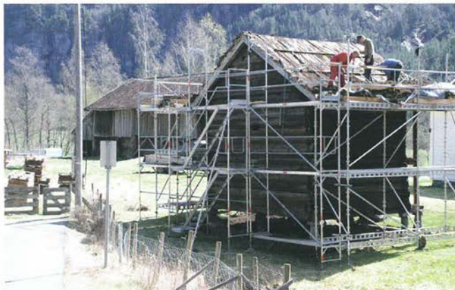
Taket på Guggedalsloftet på Kolbeinstveit vart vølt på forsommaren i 2010. Guggedalsloftet er den eldste profane trebygningen i Rogaland, og er datert dendrokronologisk til 1281.
