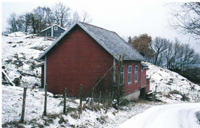
Bedehuset Sion, Fogn, som "dei unge" bygde i 1924. Det ligg berre nokre hundre meter frå bedehuset på Runestad, men striden var så hard at dei to kristenflokkane på øya ikkje kunne vera i lag.
