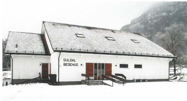
1988, Suldal, Suldal . Erstatte det gamle bedehuset.
