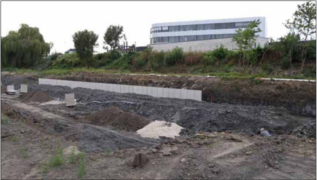
Abb. 1: Das Regenwasserrückhaltebecken nahe der Petristraße (heute gelegen an der Straße Zur Alten Gärtnerei) während der Bauphase Mitte September 2012. Im Hintergrund sieht man die Rückfront des ADAC-Gebäudes an der Eckendorfer Straße.
