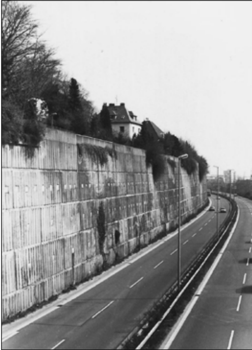
Abb. 1: Blick von der Johannistal-Fußgängerbrücke nach Norden auf den Ostwestfalendamm, Aufnahme: April 1994
