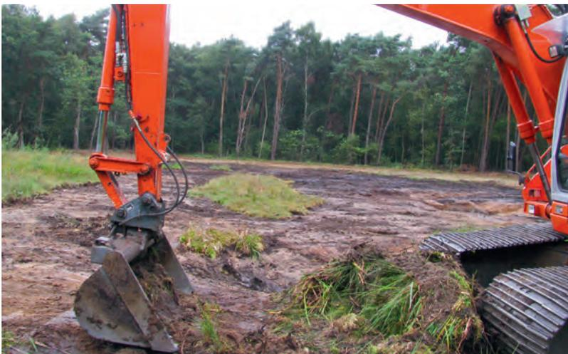
**Abb. 4:** Flaches „Abschieben“ von Flächen mit einem Bagger.
