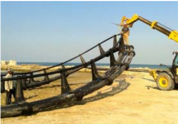
Figura 5. Jaula terminada siendo trasladada al mar
