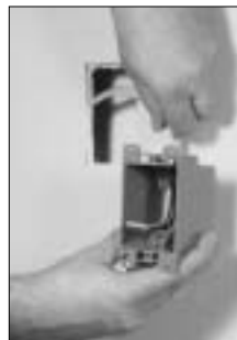
Insert Wires
