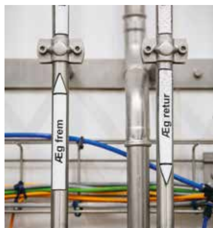
Æggene hos Pastella leveres fra DanÆg, og de pumpes gennem tynde rør ind i produktionen
