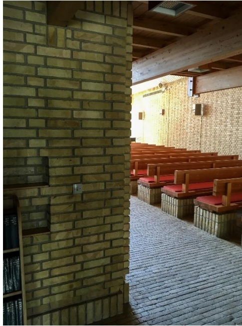
1. 3 Mursøjle ved indgangsdøren til kirkerummet
