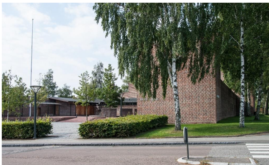
4. 4 Kirkeanlæggets gård set fra parkeringspladsen og Hvidsværmervej (SØ)
