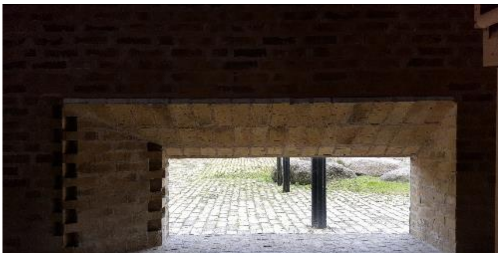
2. 9 Lavt vindue i kirkerummet
