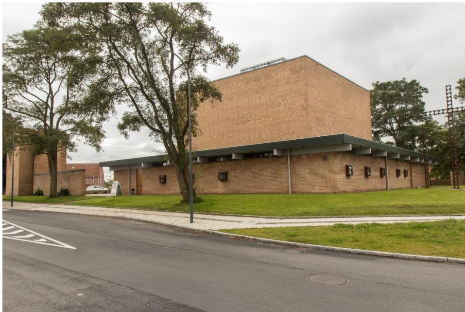
3. 2 Kirkeanlægget set fra Herlev Ringvej
