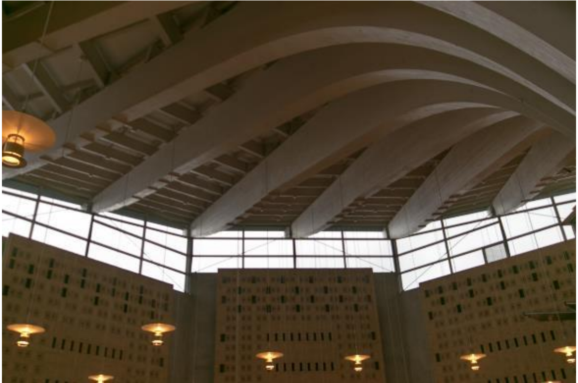
10. 9 Dagslysets indfald på søjletræets aftrappede 'grene'
