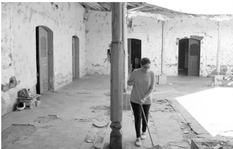
Tras cinco años de ocupación de la antigua Casa del Obrero de Rivas por parte de la PGR, es notable el deterioro del inmueble.
