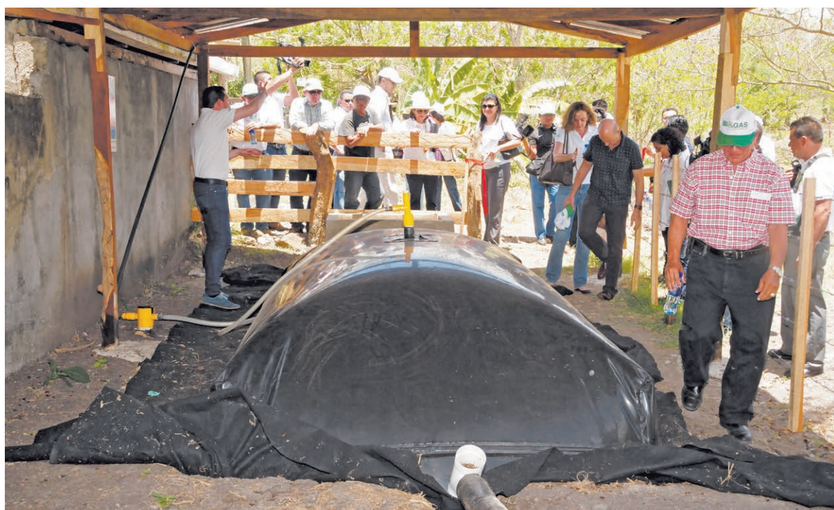
Existen diversos tipos de biodigestores. Los de geomembrana y los tubulares o de bolsa son los más accesibles, los camartec o de domo fijo son más caros, porque se construyen de concreto y bajo la tierra.
