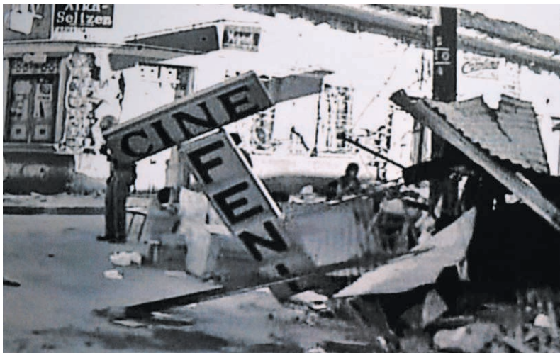
Destrozos que dejó el terremoto de 1972 del Cine Fénix.
