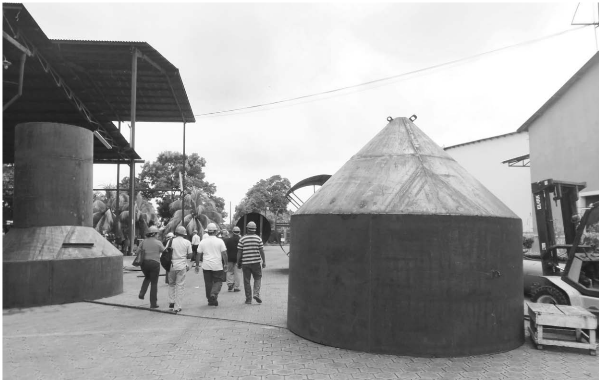
Las piezas y todo el sistema del captador de hollín se están elaborando en la misma fábrica de Casur y para el 12 de noviembre que inicie la zafra azucarera ya estarán instalados.
