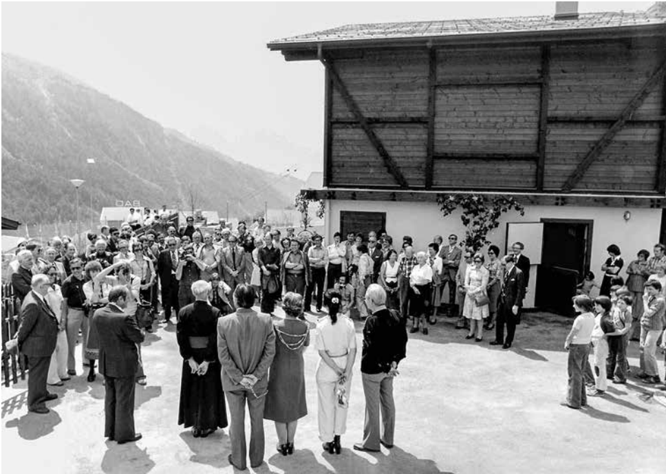
Einweihung des Landwirt- schaftsgebäudes in Breiten.
