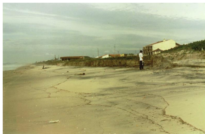
Figura 07. Cordão de dunas frontais erodido por evento de tempestade. Fonte: Souza, 1999.
