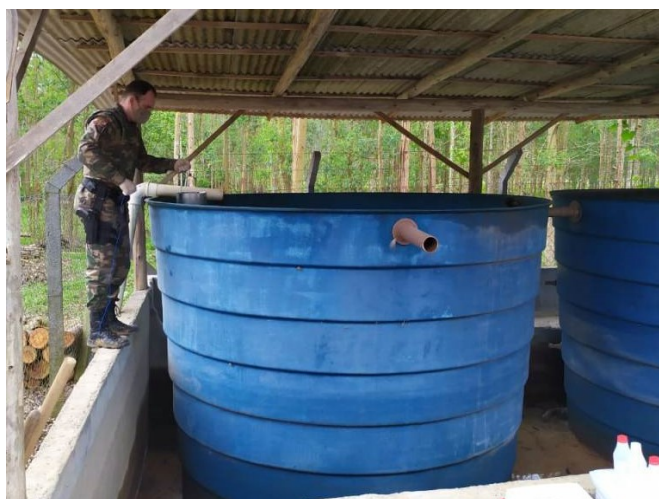
Figura 11 – Tubo de saída de efluentes ( by-pass ) encontrado no fundo do reservatório 02.
