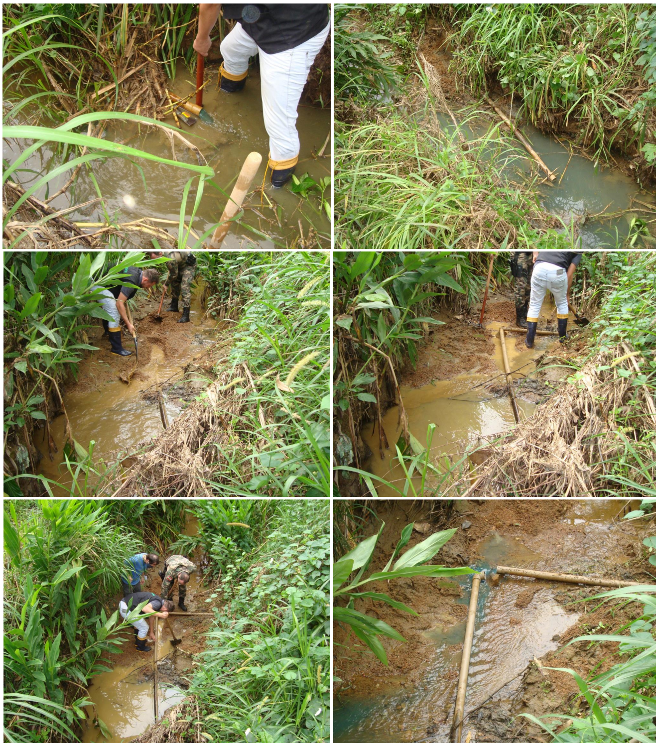
Figura 10 – Tubulação irregular para lançamento de efluente de forma contínua diretamente no curso hídrico.
