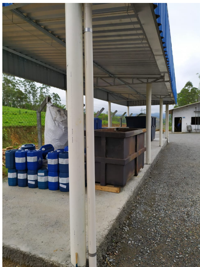
Figura 17 – Local de armazenamento de resíduos perigosos construído recentemente sem comunicação ao órgão ambiental e sem dispositivo de contenção de vazamentos líquidos.
