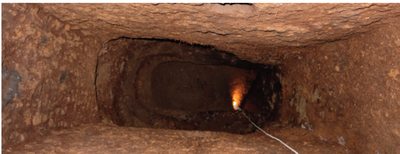
Immagine del pozzo GDS 07, in cui è possibile notare la profondità della struttura.
