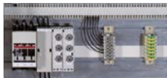
Anschlussverteiler Netz
