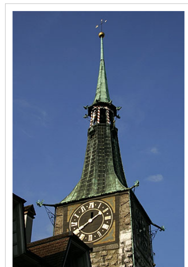
Der Zeitglockenturm (seltener Roter Turm genannt) ist das einzige Überbleibsel der mittelalterlichen Stadtburg; der Turm wurde während der Zähringerzeit etwa um 1150 errichtet.
