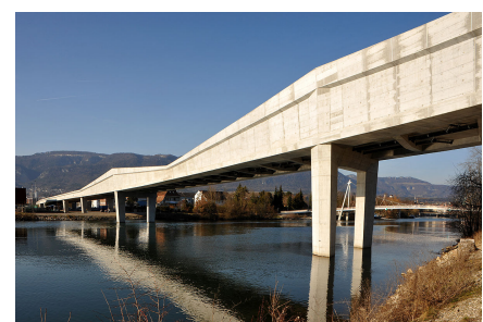
Aarebrücke der Westumfahrung, die am 8. August 2008 eröffnet wurde.
