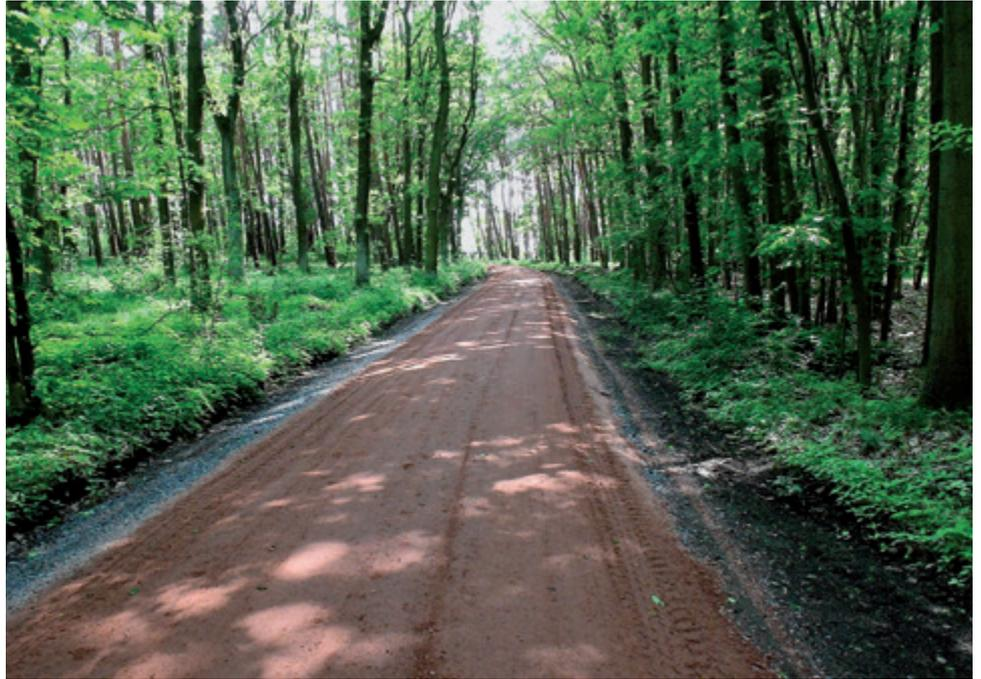
Die Landkreisverwaltung Meißen ließ im Frühjahr 2019 ein Breitbandkabel verlegen und den bestehenden Waldweg als Straße ausbauen. Standortfremde Materialien wurden 30 bis 40 Zentimeter aufgeschüttet und mit einer Schottertragschicht aus Grauwaacke und einer fünf bis zehn Zentimeter hohen Porphyrsplittschicht verdichtet. Die gesetzlich vorgeschriebene Beteiligung der anerkannten Naturschutzvereinigungen blieb aus. Foto: Renate Wilhelms
