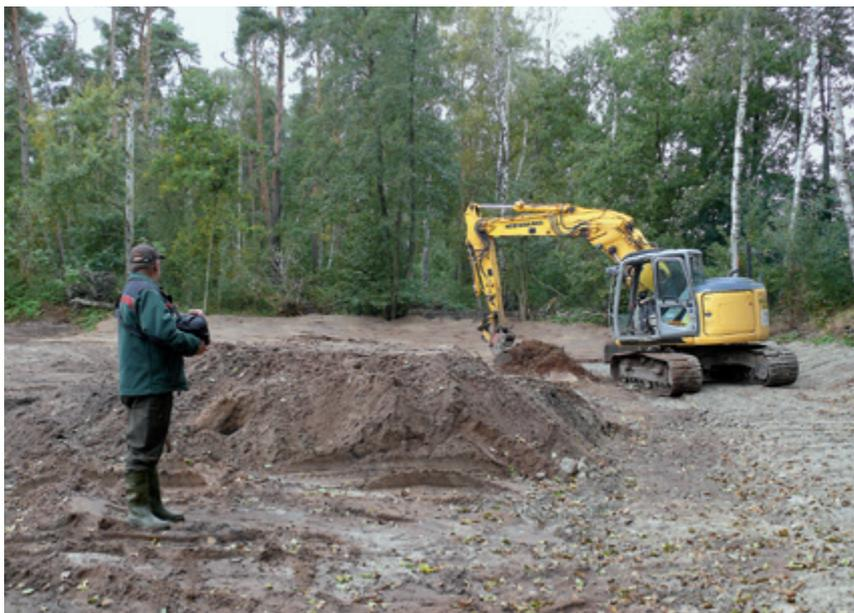
zu erwerben und die Instandsetzung seiner Wasserzuführung in die Wege zu leiten. Mithilfe einer Ausgleichsmaßnahme der Firma Gascade wurden nun Bauarbeiten realisiert, um den Pferdeteich wiederherzustellen. Der NABU Großenhainer Pflege begleitete die Freimachung der zugewachsenen Teichfläche, die Erneuerung des Teichmönches sowie den Einbau einer Dichtung am alten Teichdamm fachlich. Bereits 2019 wurde die Erneuerung der Zuflussleitung durch die Naturschutzbehörde umgesetzt.
