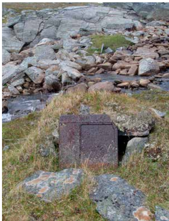
Over: Ovn til brødbaking. Opprinnelig har denne vært bygget av stein, i senere tid har det blitt tilført jernplater. Ovnen skal ha vært i bruk frem til 1960-tallet. Foto: P.M.P Sara.
