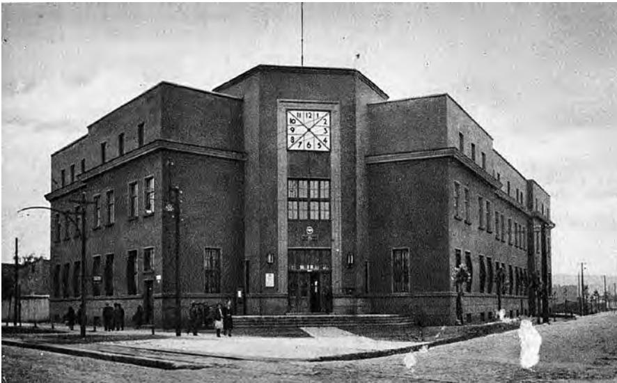
Budynek będzińskiej poczty u zbiegu ulic Kościuszki i Krasickiego. Fot. arch.
