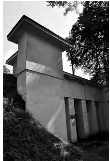
Budynek wodociągów na Wzgórzu Zamkowym. Fot. arch.
