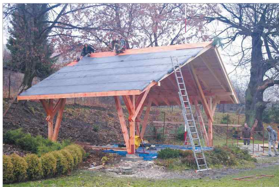
Na Słonecznym Placu w Belku trwa budowa zadaszenia nad sceną
