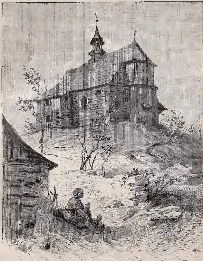
Dřevěný kostel v Klučí.
