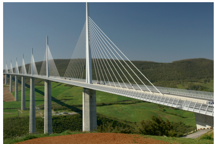
Photo n°15 – Le viaduc en service. (Photo J.-P. Muzeau)
