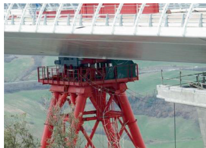
Photo n°10 - Translateur sur une pile provisoire (Photo J.-P. Muzeau)
