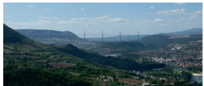
Photo n°1 – Le viaduc et la ville de Millau. (Photo J.-P. Muzeau)
