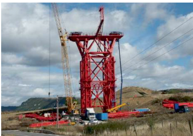
Photo n°5 – Palée provisoire T4 en cours de montage. (Photo J.-P. Muzeau)
