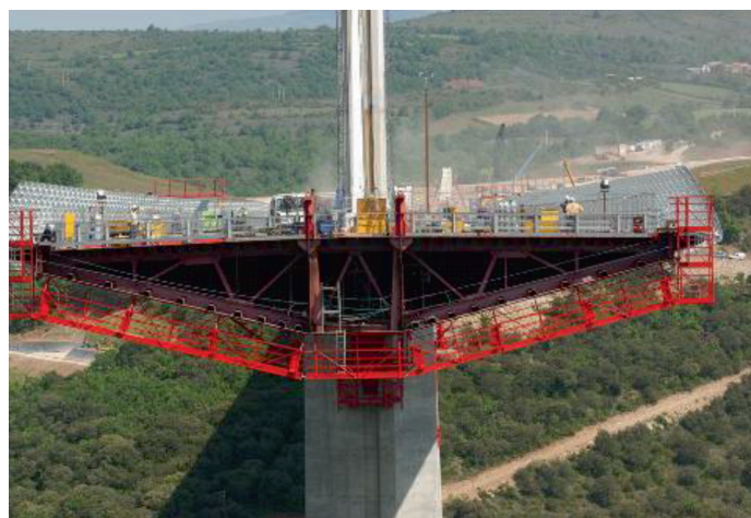
Photo n°3 – Vue dans l'axe du tablier. (Photo J.-P. Muzeau)
