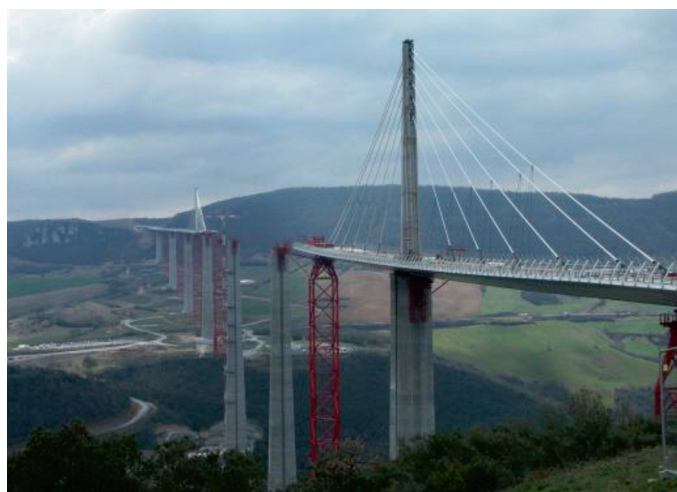
Photo n°4 – Vue des deux extrémités pendant le lancement. (Photo J.-P. Muzeau)
