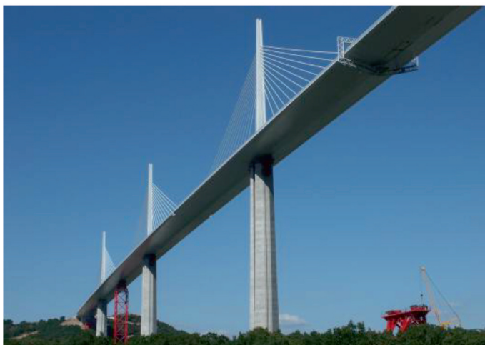
Photo n°6 - Démontage de la palée provisoire T3 après mise en place des haubans définitifs. (Photo J.-P. Muzeau)
