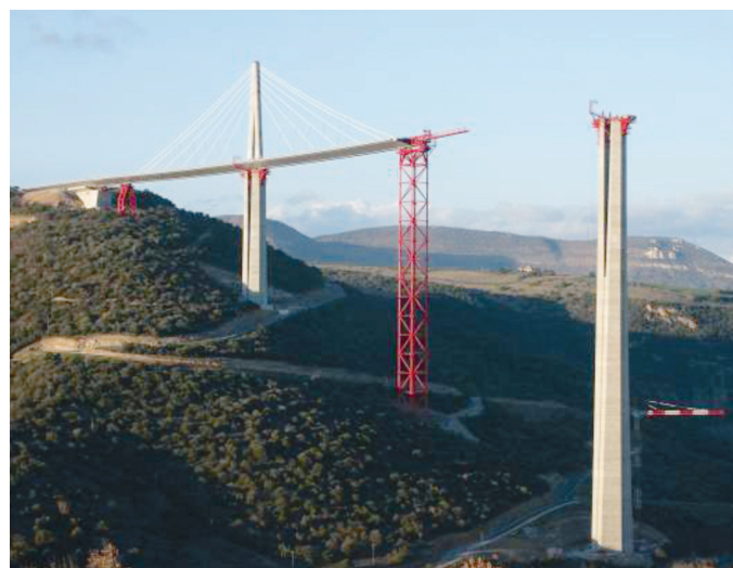
Photo n°3 – Vue des piles P1 et P2 et de la culée nord. (Photo J.-P. Muzeau)
