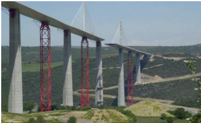
Photo n°12 – L'ouvrage avant le dernier lancement. (Photo J.-P. Muzeau)
