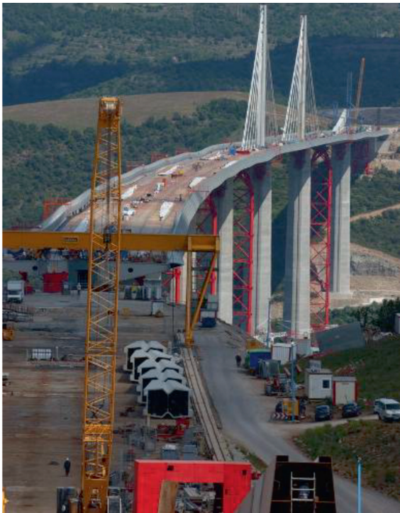
Photo n°13 – L'ouvrage après clavage des deux tronçons. (Photo J.-P. Muzeau)
