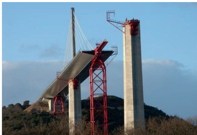
Photo n°7 - Phase de lancement où un pylône se trouve sur une pile. (Photo J.-P. Muzeau)
