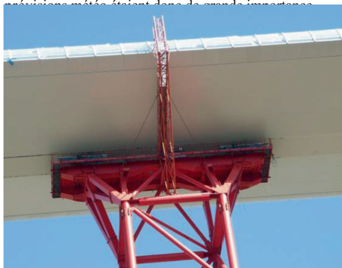
Photo n°11 – Translateurs sur une palée provisoire (Photo J.-P. Muzeau)
