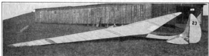
Kirchner „Hessenland“ (1929) E: W. Kirchner, Kassel; A: Niederhessischer Verein für Luftfahrt, Kassel. S: 1; St: Schw.; Bst: H. — l = 6,30 m; h = 1,00 m; b = 18,00 m; t = 1,20 m; b/t = 1 : 15,4 ; F = 21,00 m 2 ; Tg = 45,00 kg; Gr = 81,00 kg; Gz = 70,00 kg; G = 151,00 kg; G/F = 7,10 kg/m 2 .
