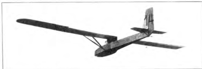
Aachen M 1 (1929) E: Mayer, Aachen; A: Luftfahrtverein, Aachen. S: 1; St: Schw.; Bst: H; P: Göttingen 535; Vs 0,72 m/s. B.-L.: D: 4:16:0'h; H: 690 m. l 6,00 m; h 2,00 m; b 14,52 m; t 1,21 m; b/t 1:12,4; F 17,00 m 2 ; Tg 79,00 kg; Lg 8,00 kg; Rg 31,50 kg; Gr 118,00 kg; Gz 70,00 kg; G 188,00 kg; G/F = 11,00 kg/m 2 .
