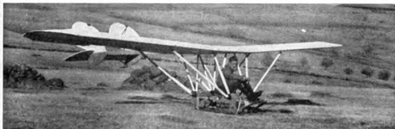
Weltensegler „Roland Festung“ (1922) E: R. Eisenlohr, Karlsruhe; A: Segelflugzeugwerke G. m. b. H., Baden-Baden. S: 1; St: Schw.; Bst: H. — l = 5,00 m; b = 11,00 m; F = 15,00 m 2 ; Gr = 100,00 kg; Gz = 70,00 kg; G = 170,00 kg; G/F = 11,30 kg/m 2 .
