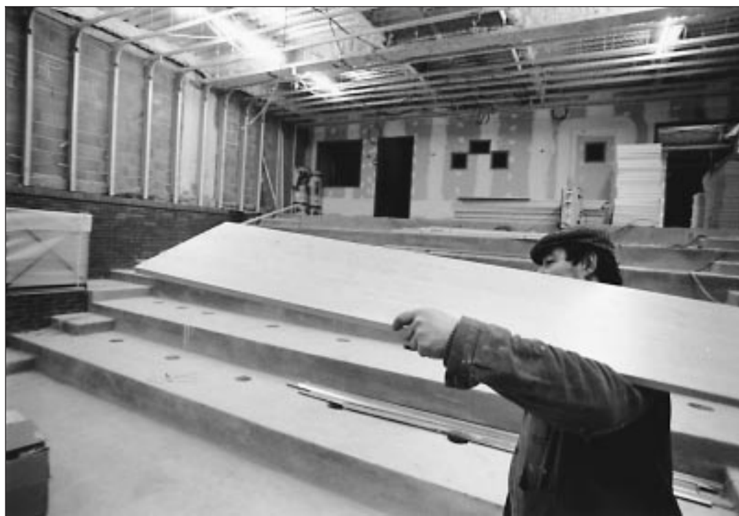
Place Michel-de-l'Hospital, les travaux de la Jetée devraient être terminés cet été, l'association Sauve qui peut le court-métrage espérant y organiser son festival 2000.
