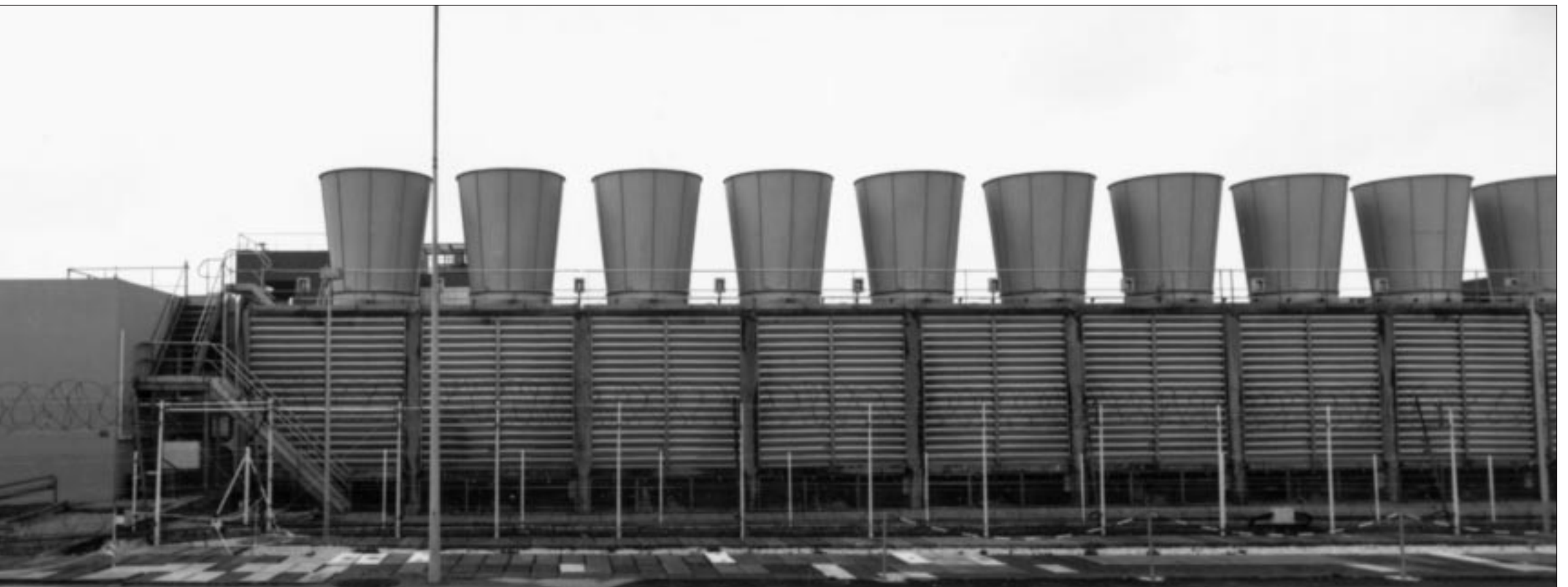
tre de retraitement des déchets radioactifs.
