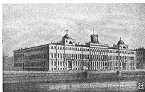
Фасад мор. корпуса в 1852 г.
