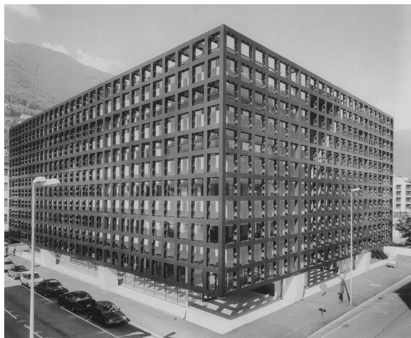
Bürohaus La Ferriera, Locarno, 2003, Arch.: Livio Vacchini, Ing.: Andreoutti + Partners
