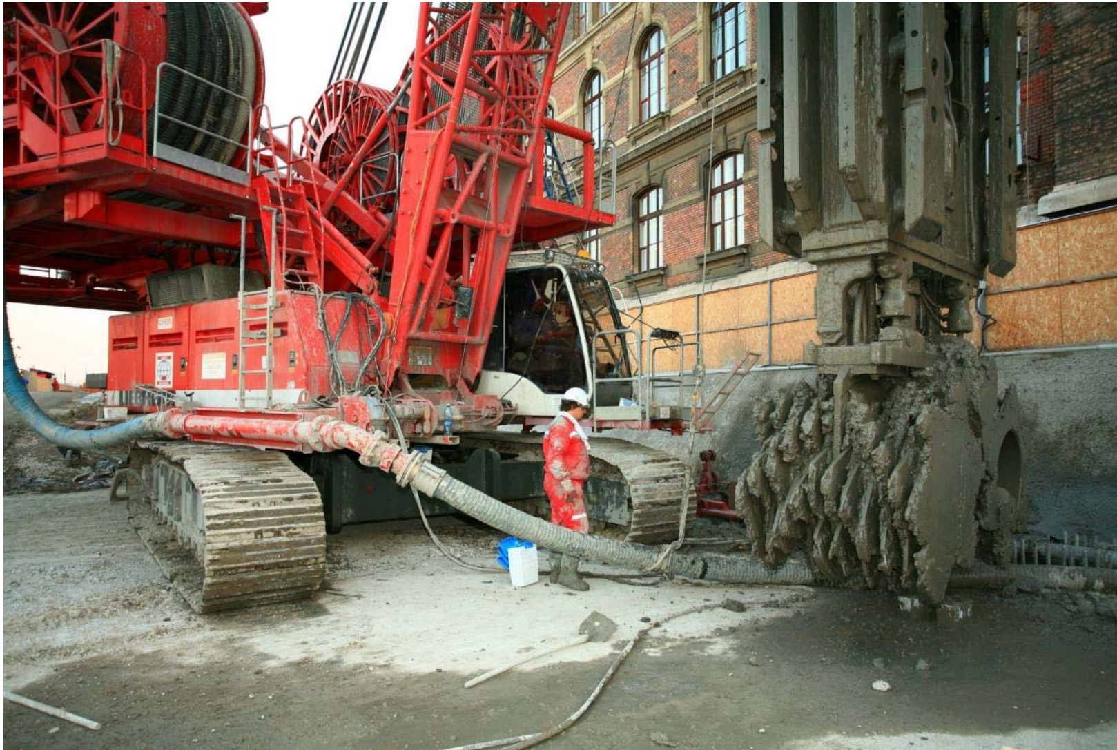
M4 Szt. Gellért és Fővám téri állomás, hidrofrezeres résfal építés
