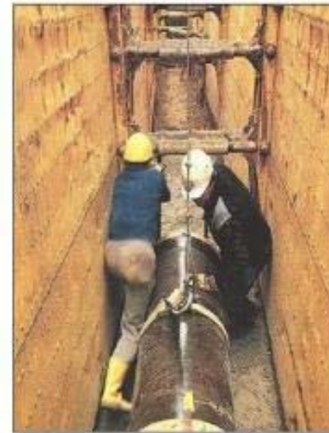
Vízszintes állított pallózás függőleges hevederekkel
