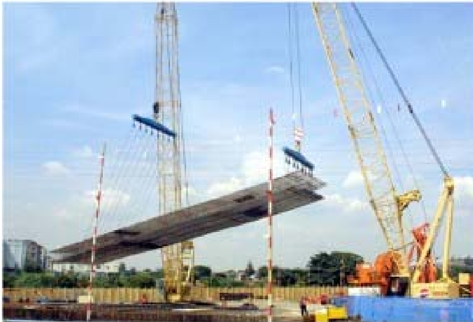
A vasalás beépítése résfalaknál
