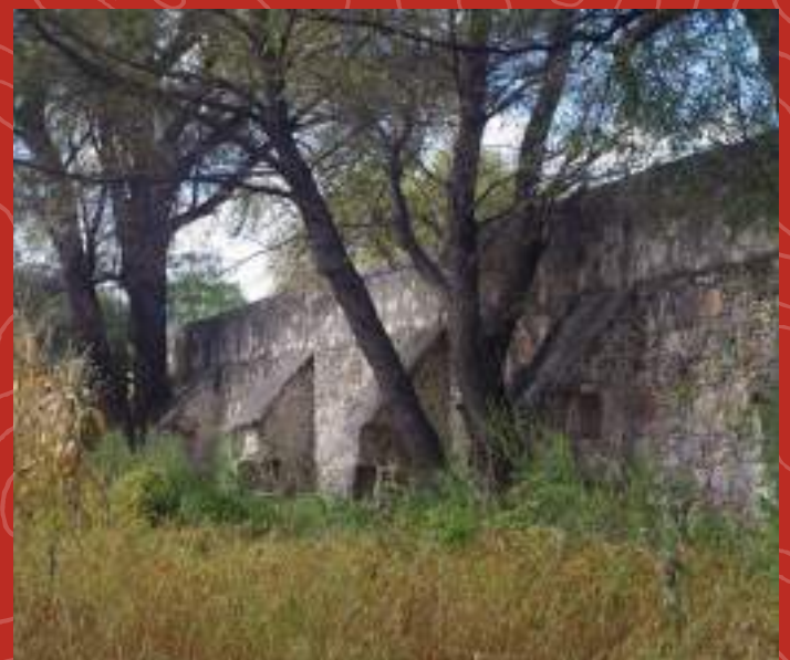
Imágenes 19, 20, 21, 22, 23 y 24. Detalles del sistema constructivo del puente San Rafael, muro de plataforma poniente, arco y sillares de intradós, espolón en lecho de río. Fotografías: Juan Antonio Patlán Salgado y Damián Bernal Vega.
