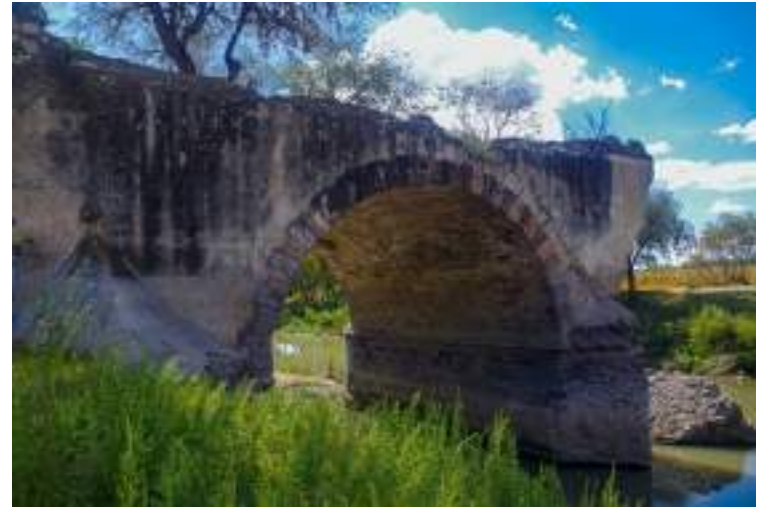
Imágenes 17 y 18. Vistas del tajamar, ubicado en la cara norte del puente y que corresponde al arranque del arco único de pie y al arco colapsado en el lecho del río. Fotografía: Juan Antonio Patlán Salgado.
