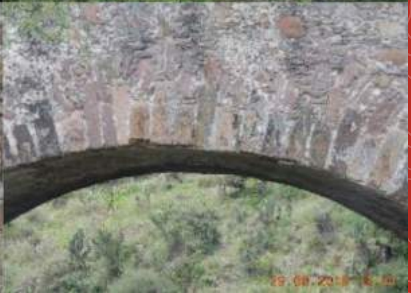
Imágenes 43, 44, 45 y 46. Detalles del sistema constructivo del puente del Fraile. Predominio de sillares sobre morteros. Autora: Elia María de la I. Morales. 2018-2019.
