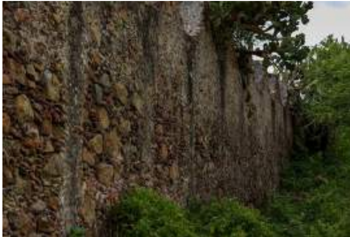
Imagen 29. Detalle de muretes del puente del Fraile. Fotografía: Damián Bernal Vega.
