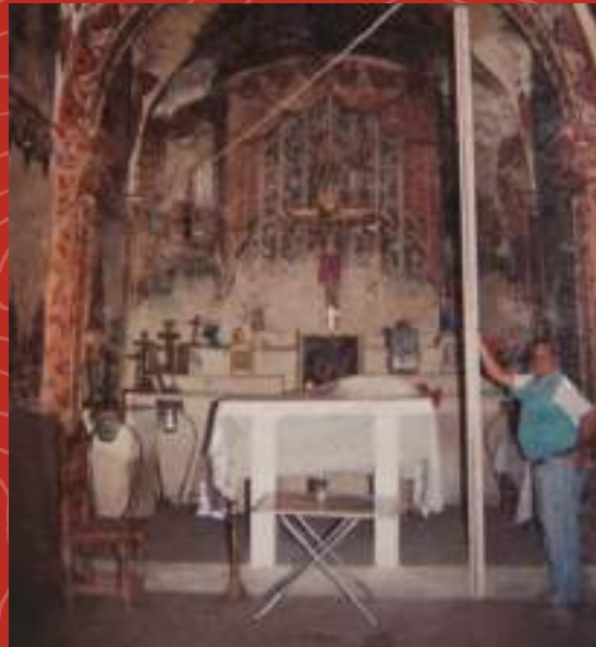
Imagen 15. Altar de la Capilla de San Isidro Capadero. Autora: Olga Adriana Hernández. 1995.
