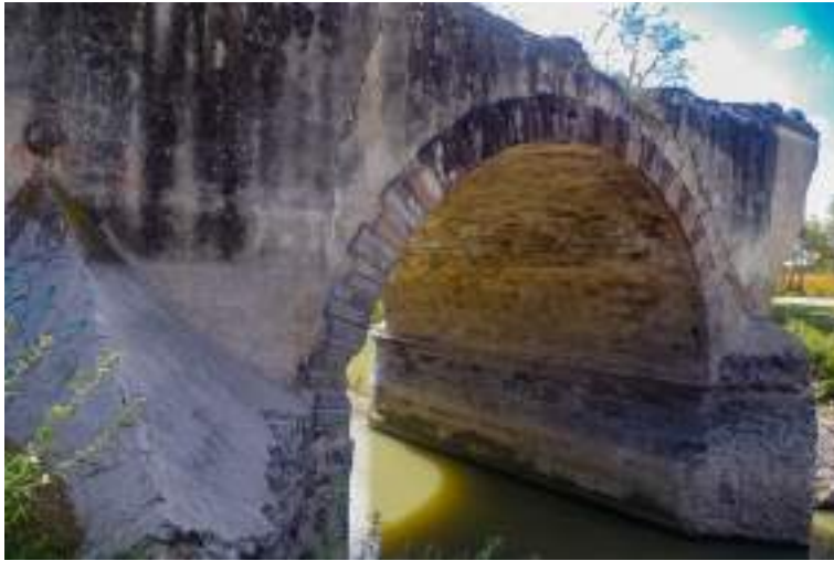
Imágenes 17 y 18. Vistas del tajamar, ubicado en la cara norte del puente y que corresponde al arranque del arco único de pie y al arco colapsado en el lecho del río. Fotografía: Juan Antonio Patlán Salgado.
