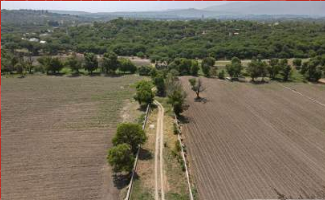
Imagen 10. Vista de dron de contrafuertes y rampa poniente del puente San Rafael. Fotografía: Secretaría de Turismo del Estado de Guanajuato.
