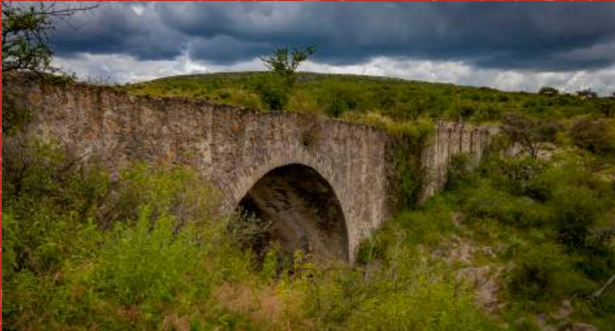
Imagen 10. El Puente del Fraile en el Camino Real a Celaya y Valladolid (hoy Morelia), San Miguel de Allende, Gto. Fotografía: Damián Bernal Vega.
