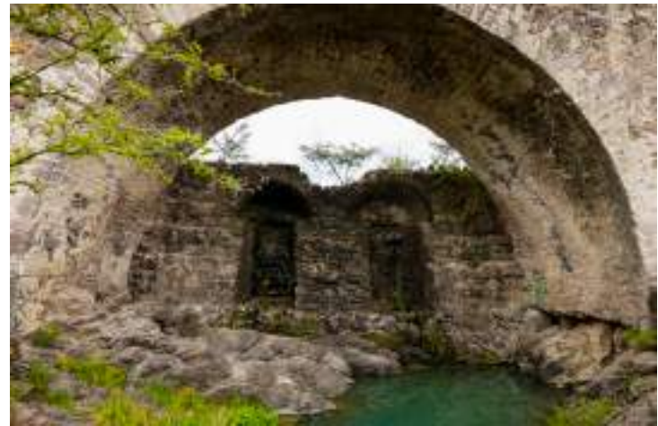
Imagen 30. Detalle de la parte central del puente del Fraile, donde aún quedan vestigios de los arcos invertidos. Fotografía: Damián Bernal Vega.
