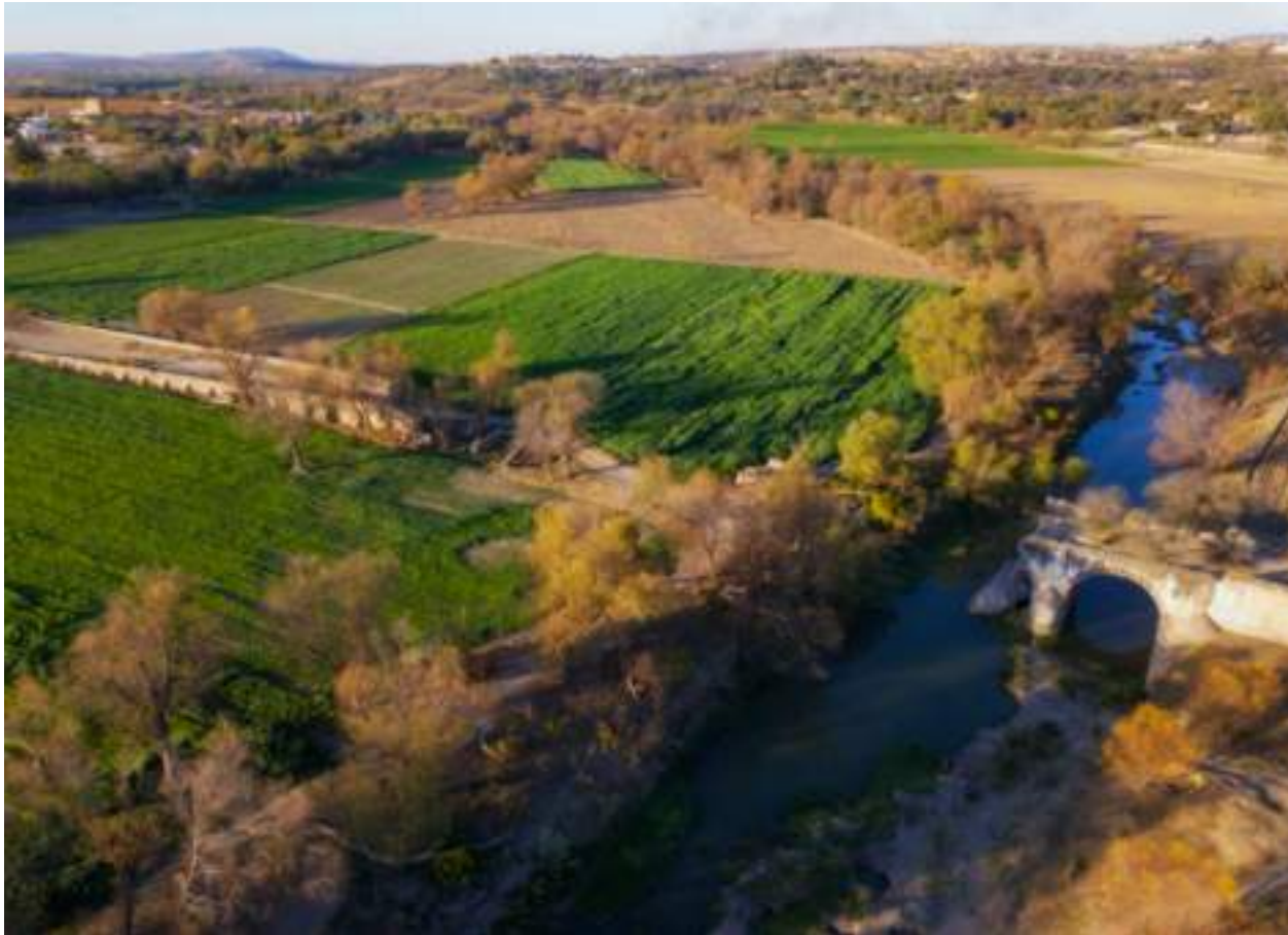
Imagen 1. Vista aérea de la calzada del puente de San Rafael. Autor: Edgar Christopher Zúñiga Ezdrone. Marzo de 2020.
