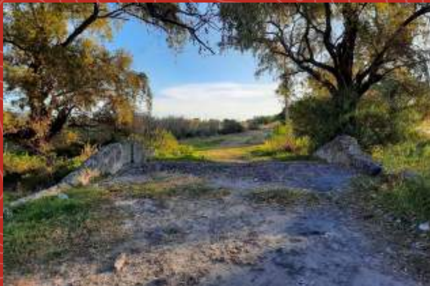
Imagen 3. Parte superior del puente. Autor: N. Gamaliel Ramírez Ortiz. 2021.
