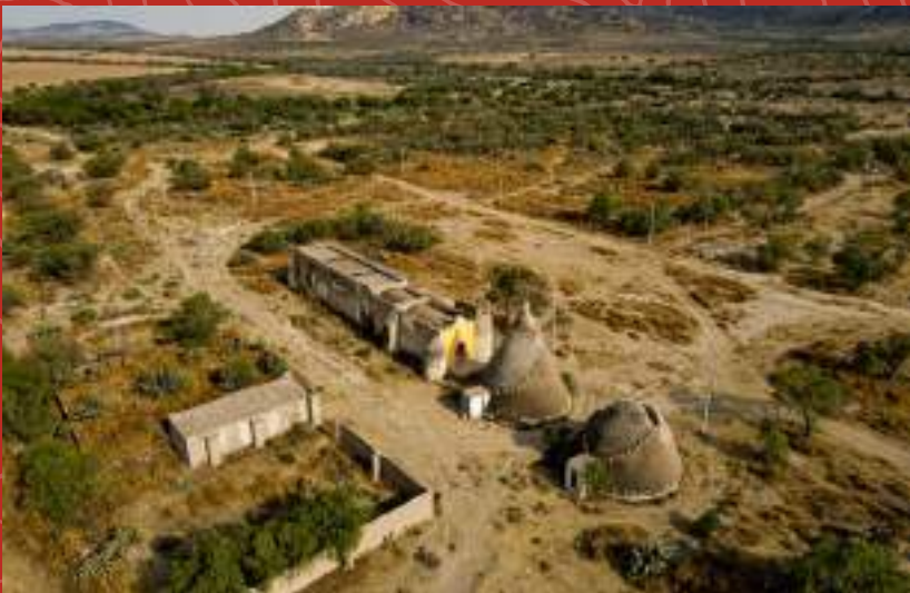
Imagen 10. Vista panorámica de la Hacienda El Vigil, perteneciente al municipio de San Felipe. Destacan los silos construidos a base de adobe y aplanado a la cal en forma de conos, uno de ellos colapsado a causa de un rayo. Fotografía: Ing. José Antonio Juárez Rivera.
