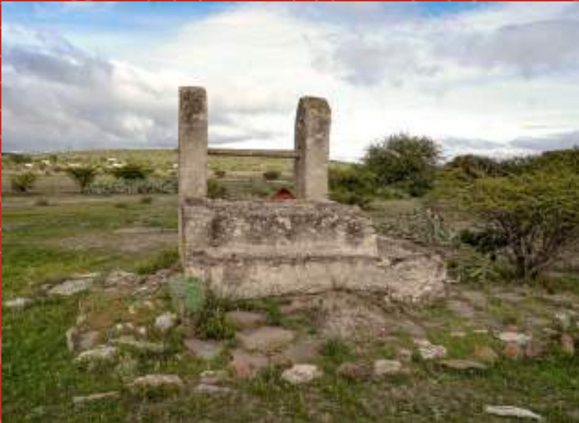
Imagen 36. Noria construida a base de piedra caliche (característica en la zona) y cal. Cuenta con un abrevadero adosado. Se ubica sobre el Camino de la Plata, entre el actual San José Iturbide y San Luis de la Paz. Fotografía: Secretaría de Turismo del Estado de Guanajuato (SECTUR).
