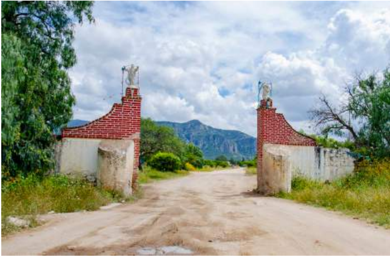
Imagen 2. Acceso principal de la Hacienda San Andrés del Cubo del municipio de San Felipe.
