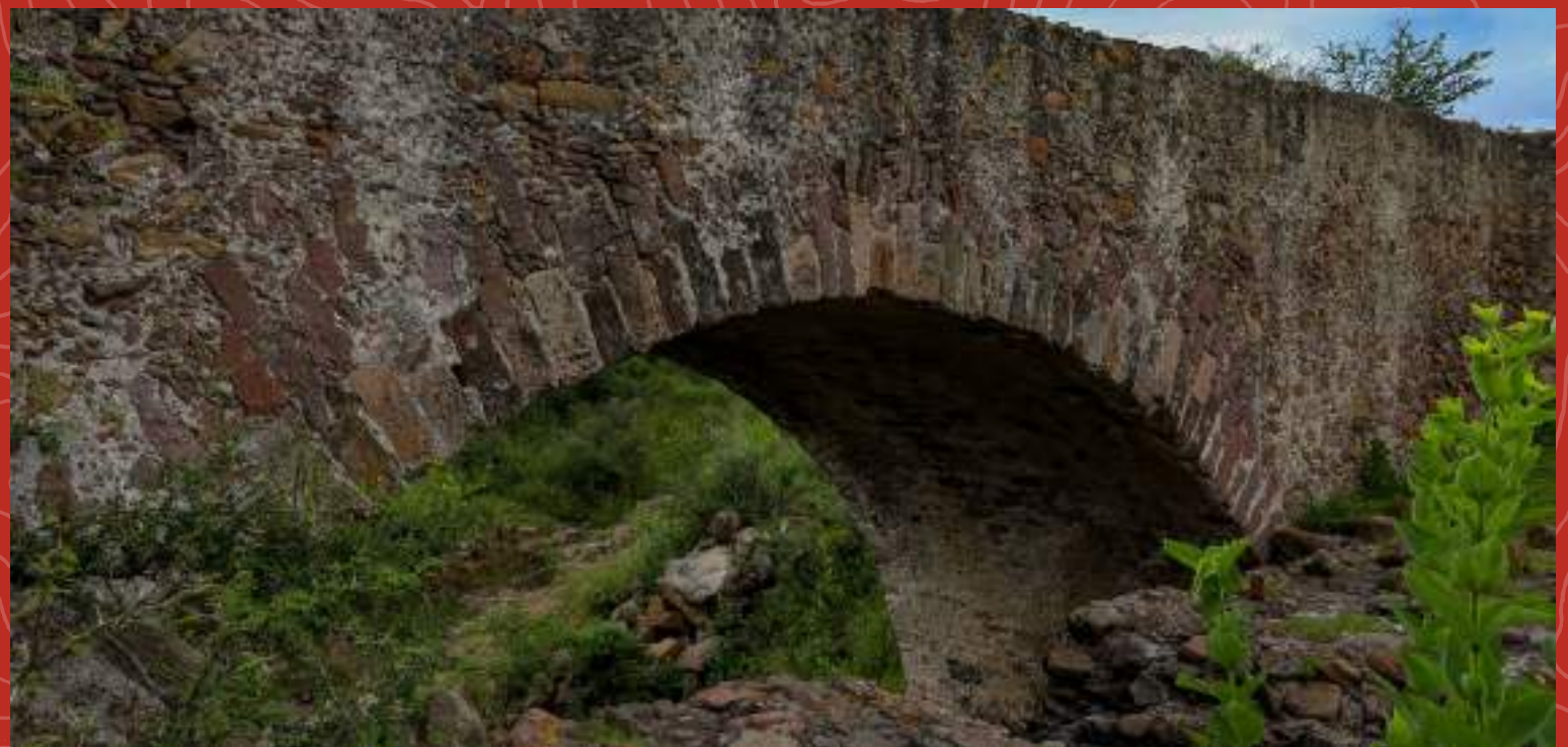
Imágenes 31, 32, 33 y 34. Detalles de la represa en el puente del Fraile. Fotografías: Damián Bernal Vega.
