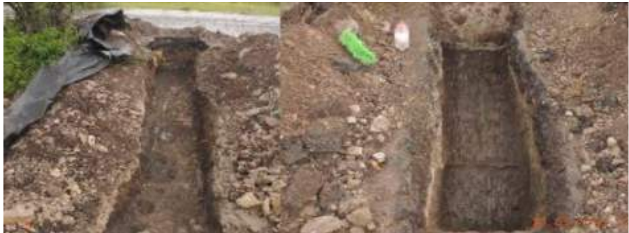
Imágenes 37 y 38. Detalles del empedrado encontrado en el nivel original del piso del puente. Autora: Elia María de la I. Morales. 2019.
