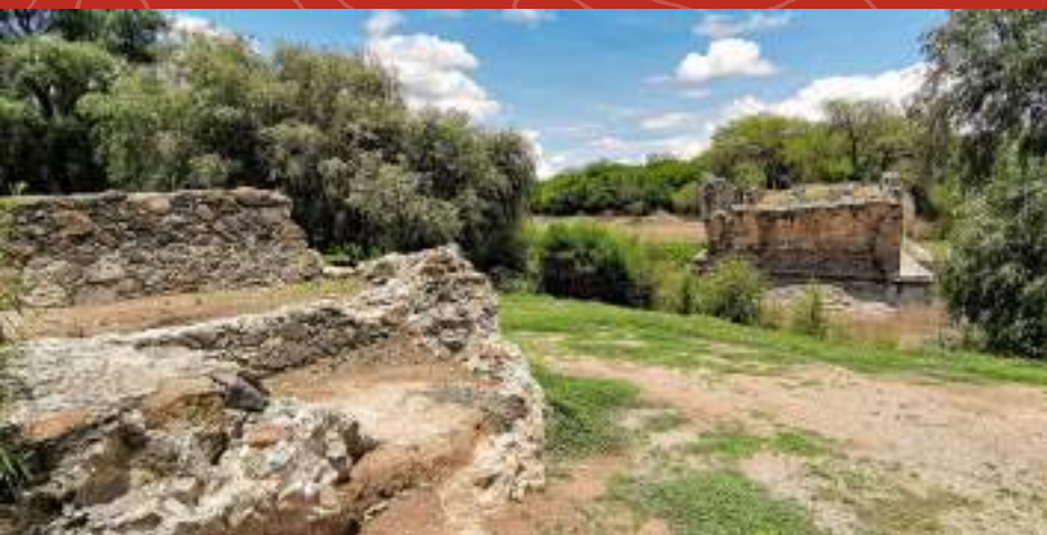
Imágenes 15 y 16. Emplazamiento del tejido estructural del puente, en la margen poniente, donde se encontró el espolón de dimensiones similares al que franquea a la margen oriente, el arranque de los arcos que habrían de estar sobre el afluente, en dirección de oriente a poniente. Fotografía: Secretaría de Turismo del Estado de Guanajuato.
