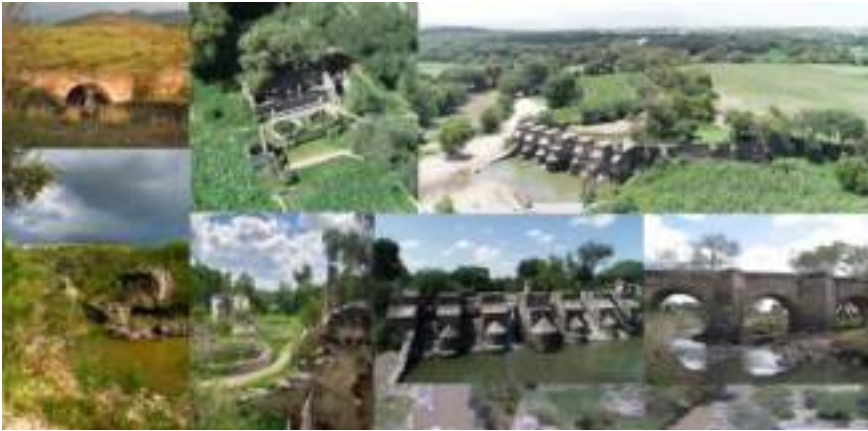
Imagen 11. Infraestructura hidráulica en el río Laja y en ríos adyacentes. Fotografías: Elia María de la I. Morales. Años 2019 a 2020.
