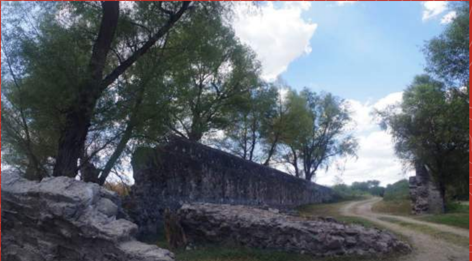
Imagen 10. Calzada del puente de San Rafael donde aún se puede apreciar parte del empedrado. Autor: Juan Antonio Patlán Salgado. Marzo de 2021.
