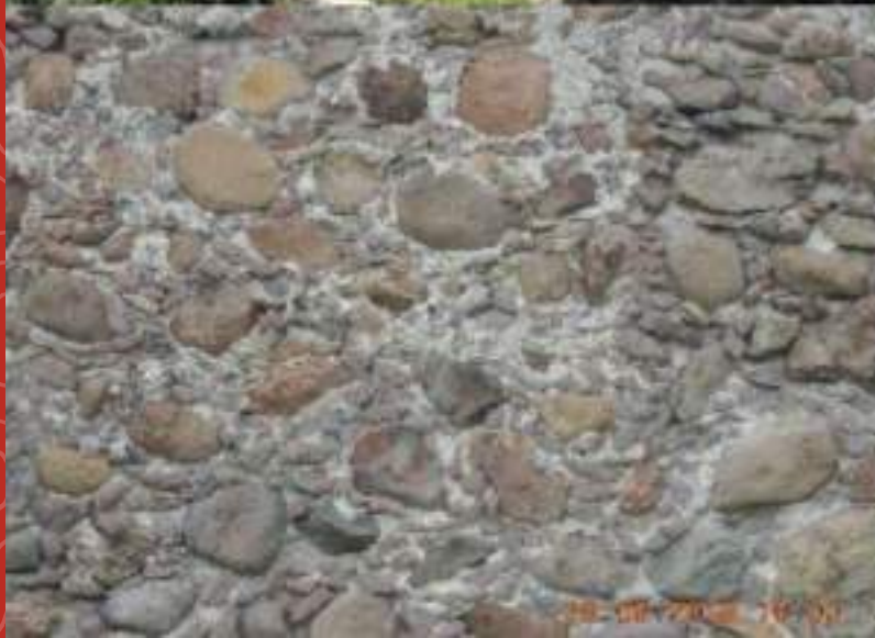
Imágenes 43, 44, 45 y 46. Detalles del sistema constructivo del puente del Fraile. Predominio de sillares sobre morteros. Autora: Elia María de la I. Morales. 2018-2019.
