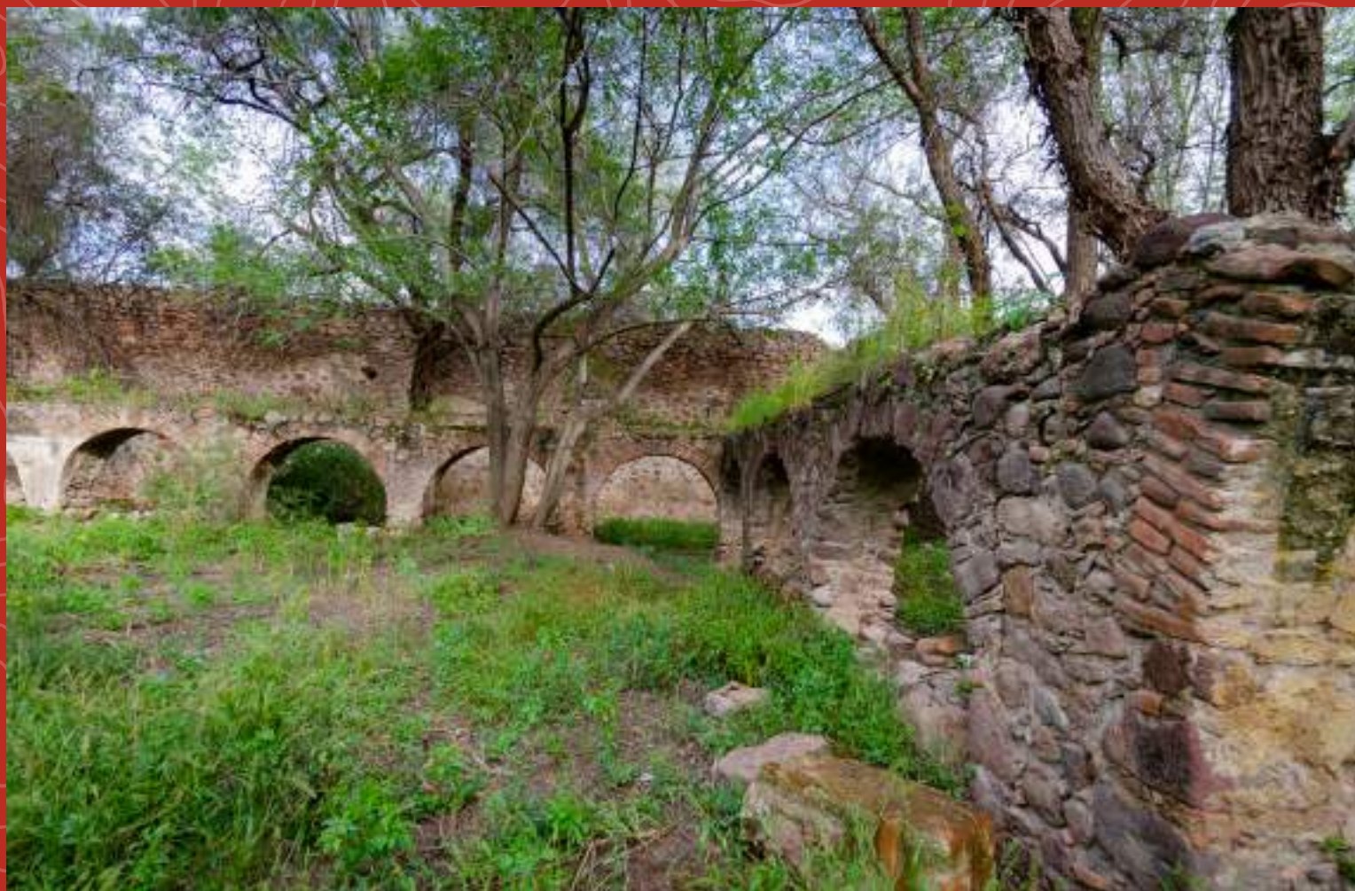
Imagen 3. Hacienda de la Erre, construida en el transito del Camino Real de Tierra Adentro, entre los siglos XVI y XVII. Fotografía: Damián Bernal Vega.
