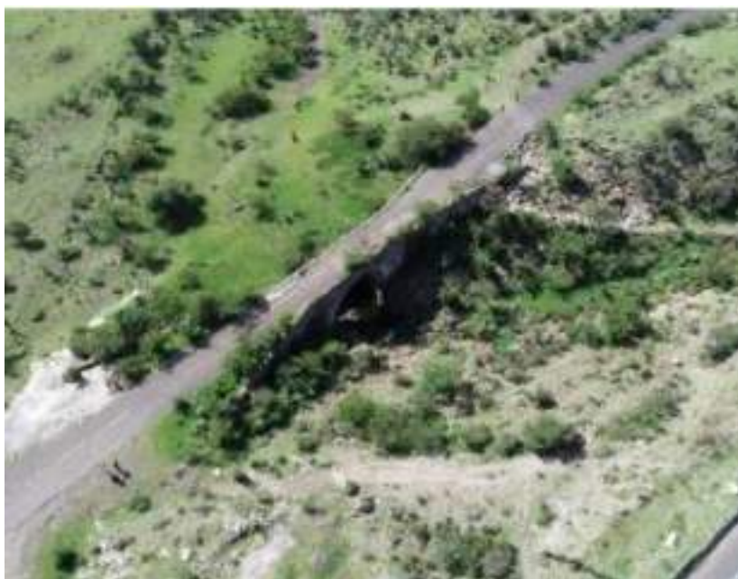
Imagen 39. Vista aérea del puente del Fraile. Vista de dron. Autora: Elia María de la I. Morales. 2019.
