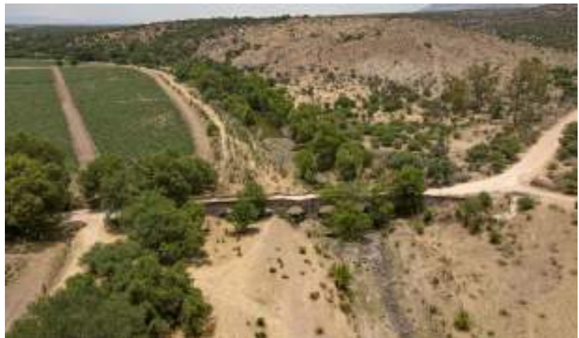
Imagen 2. Puente de la Quemada. Vista aérea. Fotografía: Secretaría de Turismo del Estado de Guanajuato.
