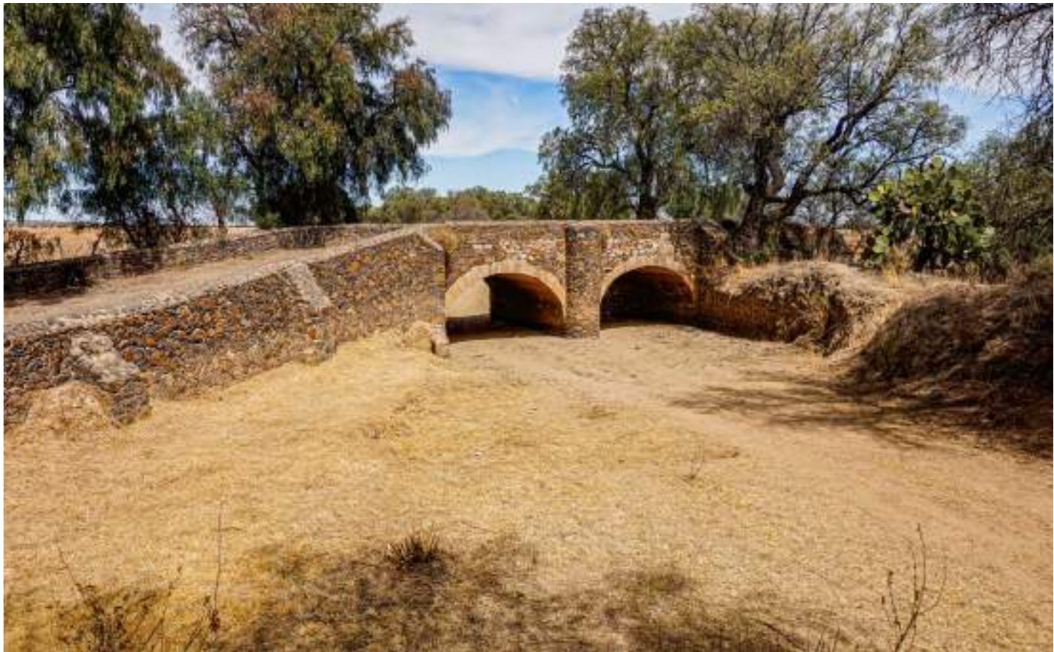
Imagen 1. El Puente Negro, ubicado en el camino a Comanja de Corona, en el municipio de Ocampo. Fotografía: Ing. José Antonio Juárez Rivera.
