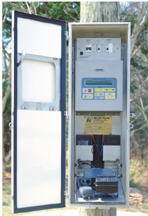
Figura 5.12. Gabinete de control típico de los reconvertadores serie Nulec
