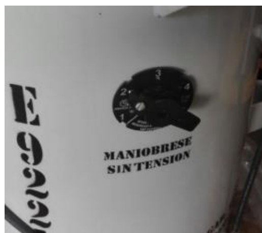
Figura 4.30. Conmutador de tomas de transformador MT/BT monofásico
