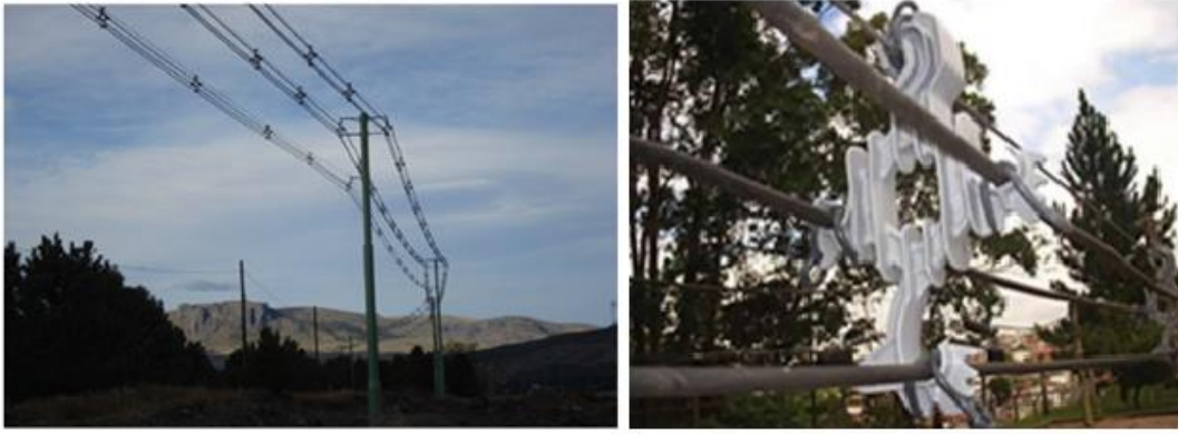
Figura 4.18. Línea compacta y distanciador de conductores
