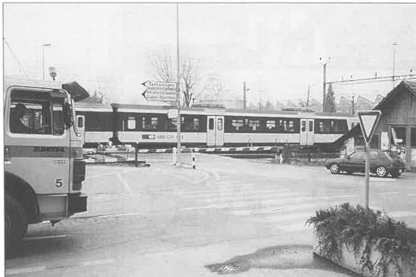
Rothenburg: Der Niveauübergang Rothenburg-Station verschwindet. Der Bund genehmigte die Beiträge.
