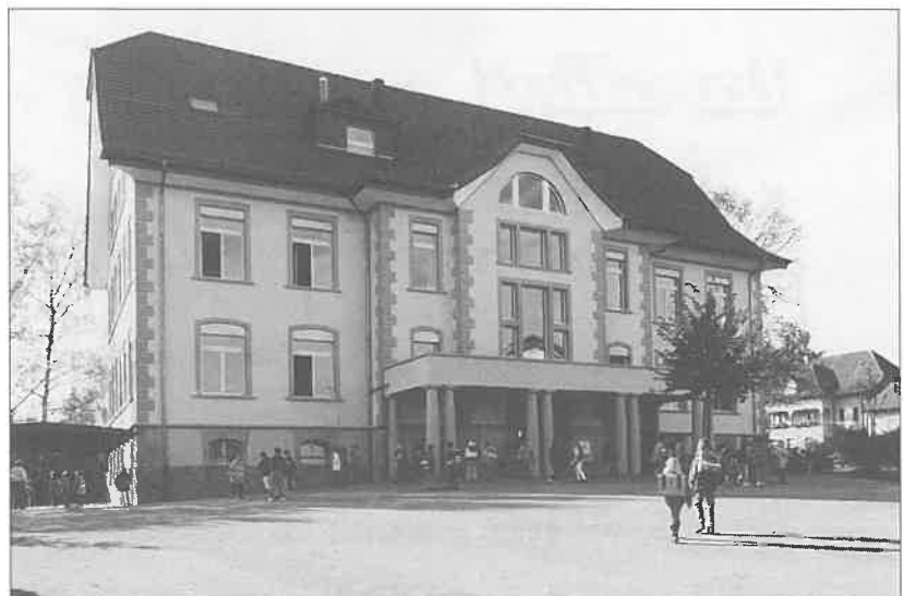
Hochdorf: Peter-Halter-Schulhaus nach der Renovation in neuem Glanz.
