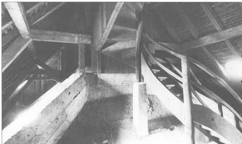
Hochdorf: Romantische Dachkonstruktion in der Braui, kurz vor dem Abriss.
