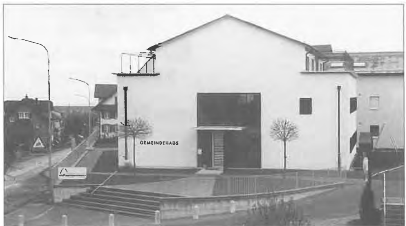
Römerswil: Das neue Gemeindehaus im Dorfkern.
