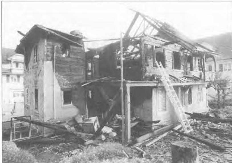
Rain: Die kläglichen Überreste des Hauses Hauptstrasse 13.
