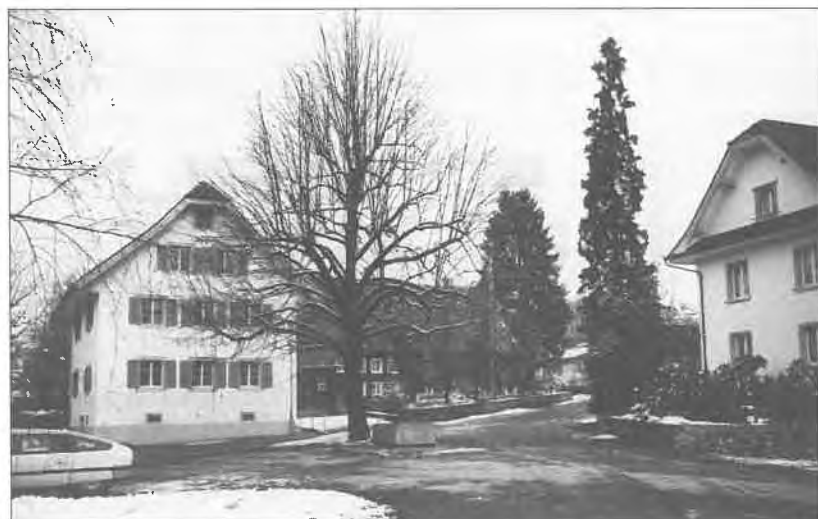
Altwis: Die Renovation des alten Schulhauses kurz vor der Vollendung.
