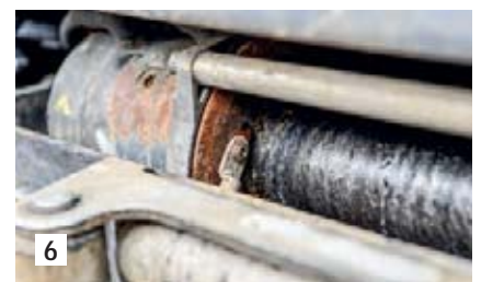
6 Jetzt kommt man vernünftig an die Schraube, die den Kabelschuh an der Trommel hält.
