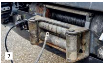
7 Das Seil kann nun komplett herausgezogen und beiseite gelegt werden. Das neue ...
