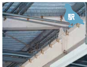
設置面に対して外側に 張り出す形状を 取っているためハト が止まれません。 (II-N型)
