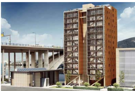
Immeuble Treet, Bergen, en construction
