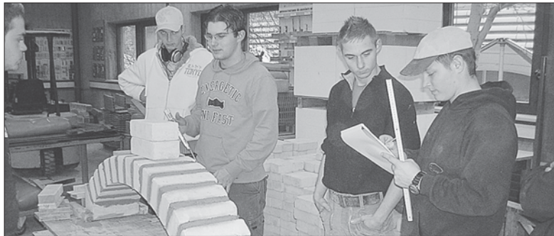
Schülerinnen und Schüler mauern in der Bauwerkstatt der Zeppelin-Gewerbeschule an einem Projekthäuschen. Im Vordergrund werden Hölzer für ein Holzhaus vorbereitet.
