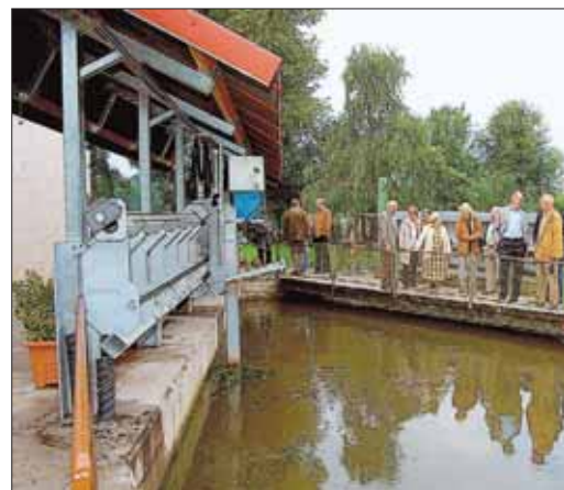
Einweihungsfest konnte am Kraftwerk Lindenhain in Singens Süden letzten Mittwoch gefeiert werden. Neben dem neuen Stauwehr und der 50 Meter langen Fischtreppe wurde auch der Grüngürtel komplett neu gebaut. swb-Bild: of
