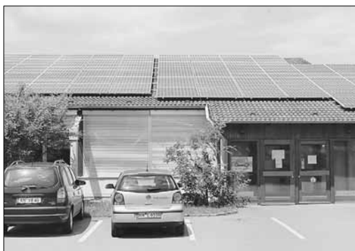
Die Kfz-Zulassungsstelle in Singen wird umgebaut. Hierzu kam grünes Licht vom Bauausschuss des Kreistages. swb-Bild: frö
