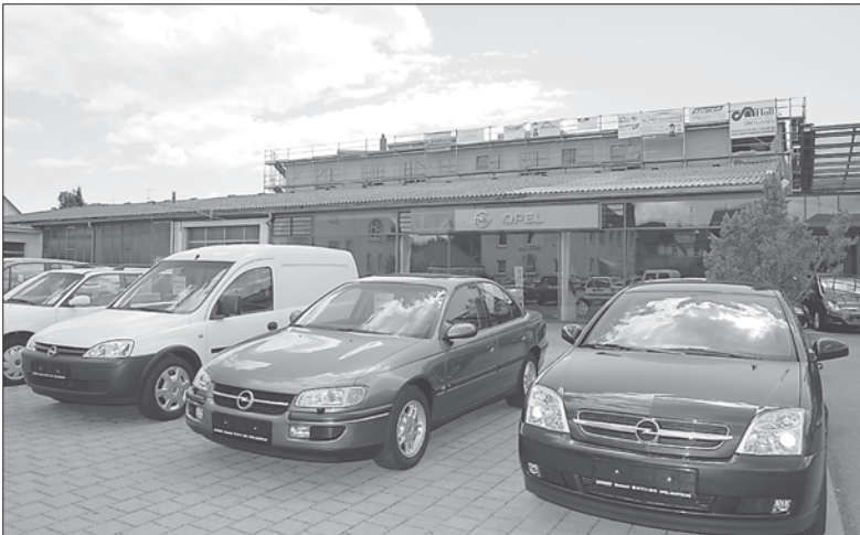
Hinter »Opel Martin« in Stockach wurde ein bestehendes Gebäude saniert, renoviert, umgebaut und aufgestockt. In dem Haus werden Büros und Wohnungen vermietet. swb-Bilder: Weiß
