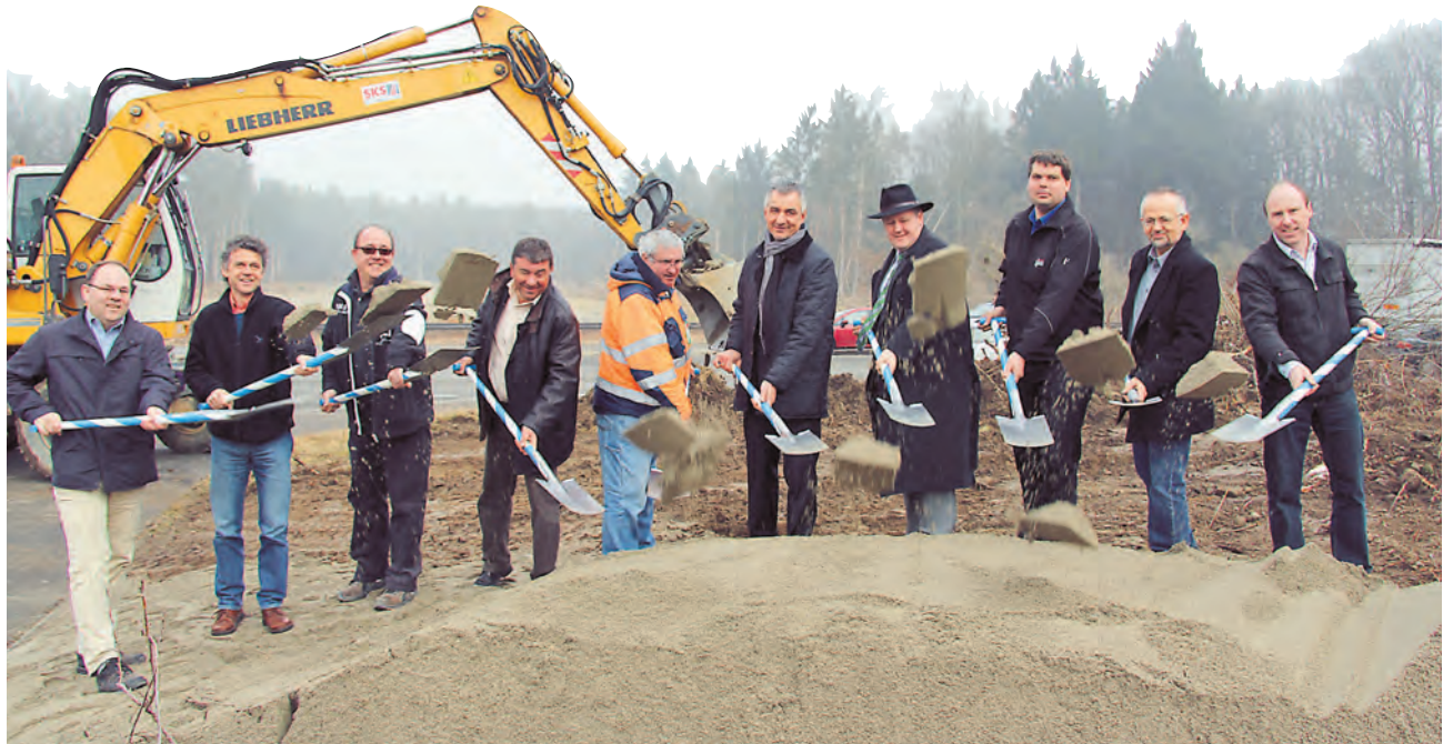
Viele Spaten waren im Einsatz für den offiziellen Baustart an der Mittelspange Ost. Nach 37 Jahren Planung geht es nun an die Verwirklichung des für die Entlastung der Singener Innenstadt wichtigen Projekts. swb-Bild: Huber
