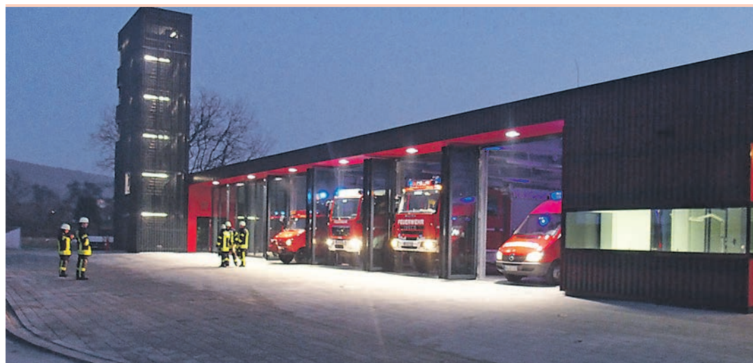
Das neue Feuerwehrgerätehaus macht auch bei Nacht eine »gute Figur«. Das Gebäude wird am 17. April um 18.30 Uhr anlässlich der Feierlichkeiten zum 150-jährigen Bestehen der Freiwilligen Feuerwehr Steißlingen und des 50-jährigen Bestehens des DRK Ortsvereins an seine ersten Nutzer übergeben.
