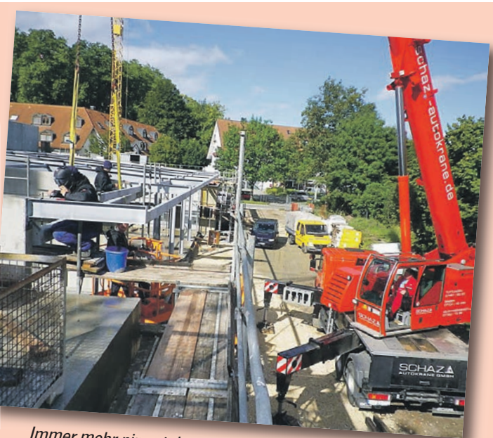
Immer mehr nimmt das Steißlinger Feuerwehrgerätehaus während des Baus Konturen an. Das Stahlgerüst der Fahrzeughalle ist fertiggestellt.
