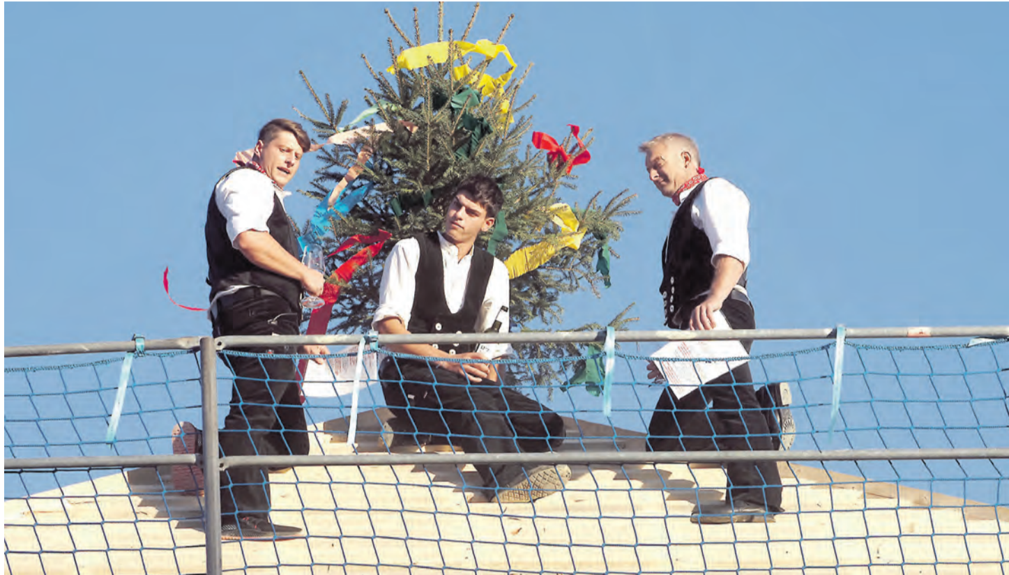
Die Eigeltinger Zimmerer des Unternehmens Martin beim kühnen Richtspruch aus kühner Höhe markierten einen weiteren Meilenstein für das neue Fastnachtsmuseum bei Schloss Langenstein. swb-Bild: Oliver Fiedler
