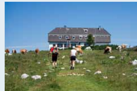
Das Hochleckenhaus der ÖAV-Sektion Vöcklabruck erfüllt besonders hohe Umweltstandards und bemüht sich um energieeffizientes Wirtschaften. Dafür wurde die Hütte mit dem Umweltgütesiegel des Österreichischen Alpenvereins ausgezeichnet.
