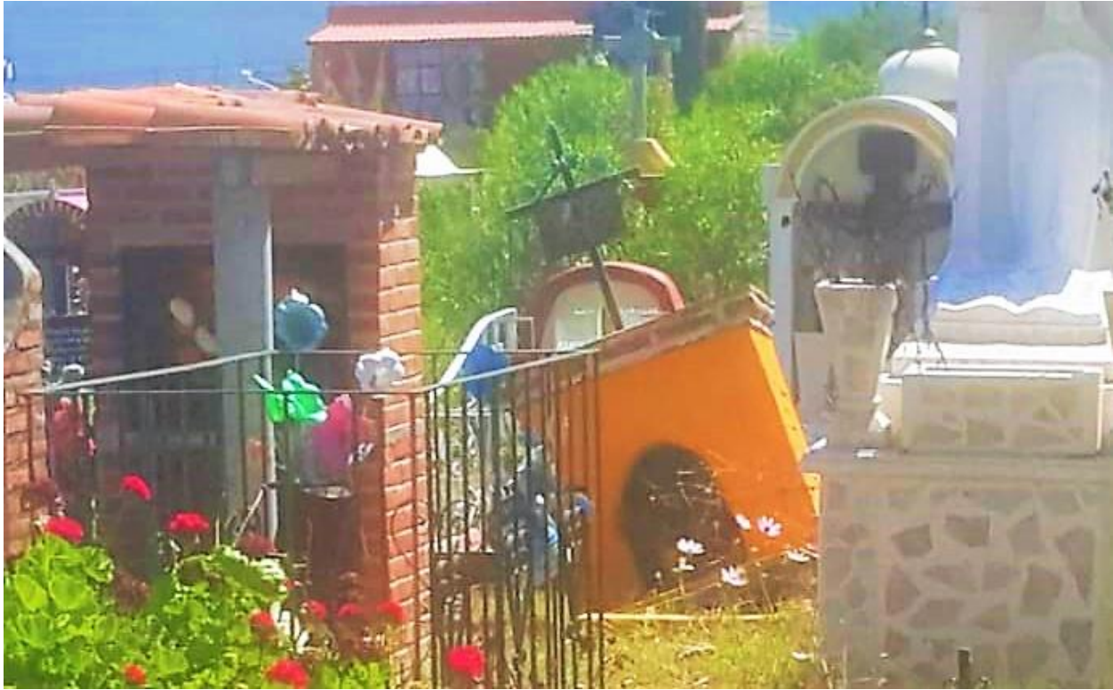
Estructuras en mal estado
