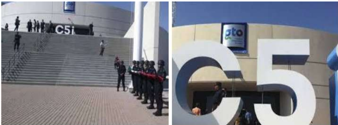
Imagen 17. Edificio C5i, Centro de Operaciones
