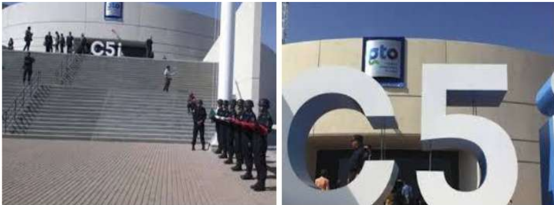
Imagen. Edificio C5i, Centro de Operaciones
