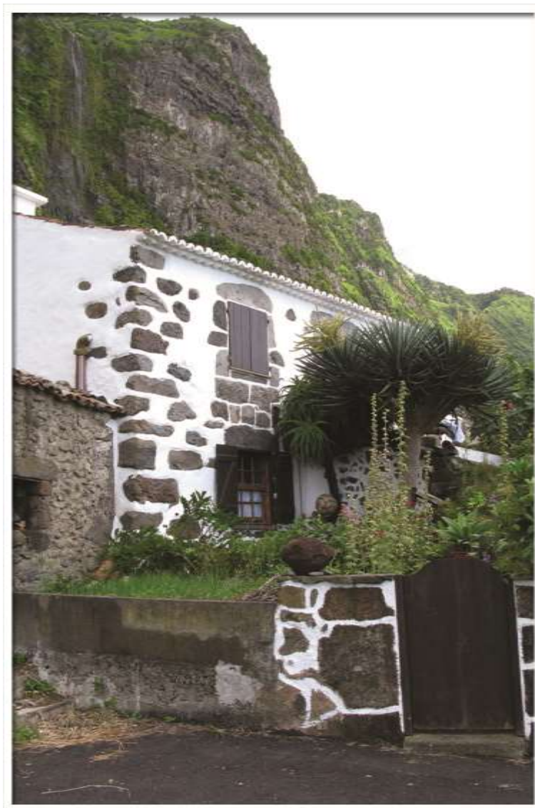
Figura 24. Casa em pedra à vista e pedra caiada.
