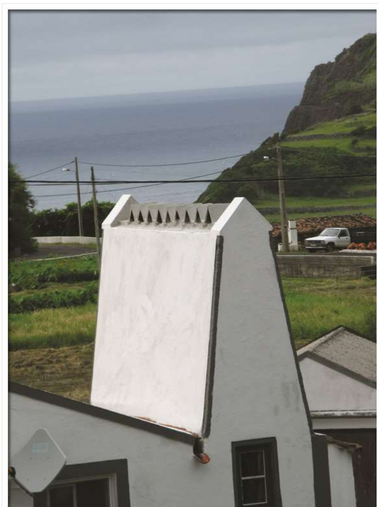
Figura 27. Detalhe de chaminé tradicional.
