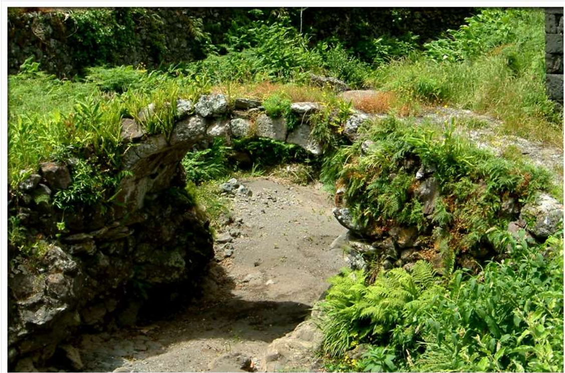
Figura 18. Antiga ponte de pedra em arco construída pelos Espanhóis (Vila das Lajes).
