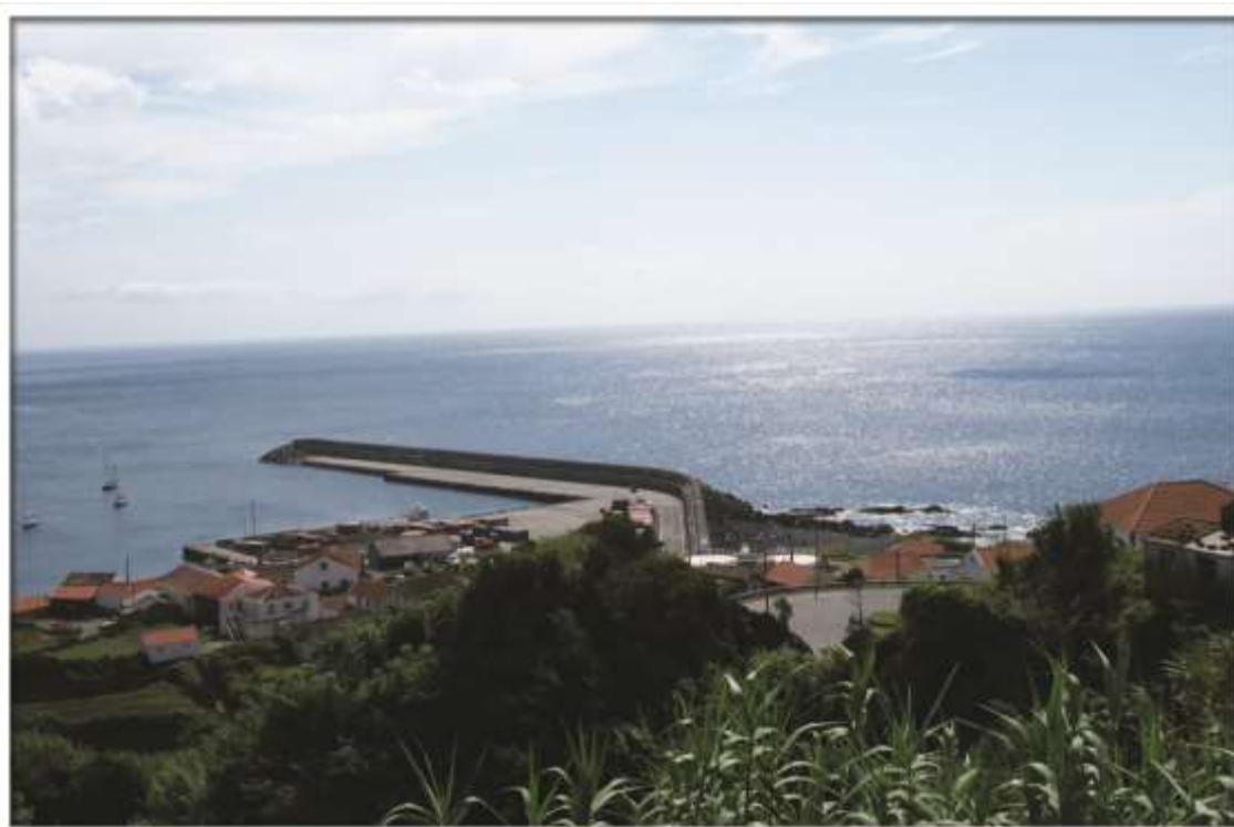
Figura 63. Porto das Lajes.
